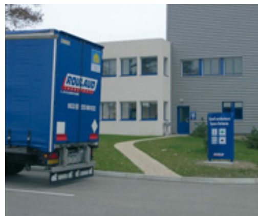
Photo 7.10. Emplacement du local d'accueil des conducteurs.
