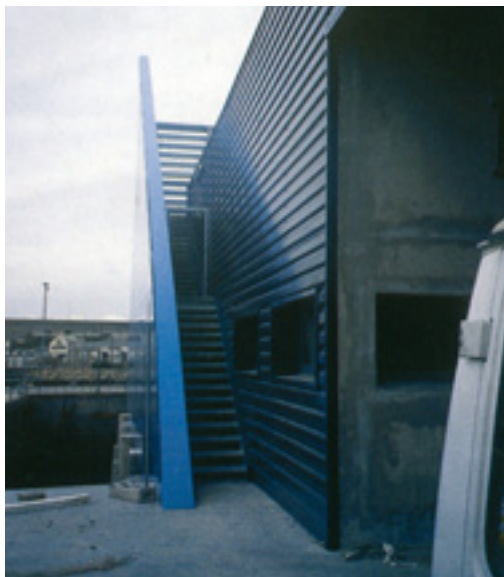
Photo 8.1. Accès en toiture.
