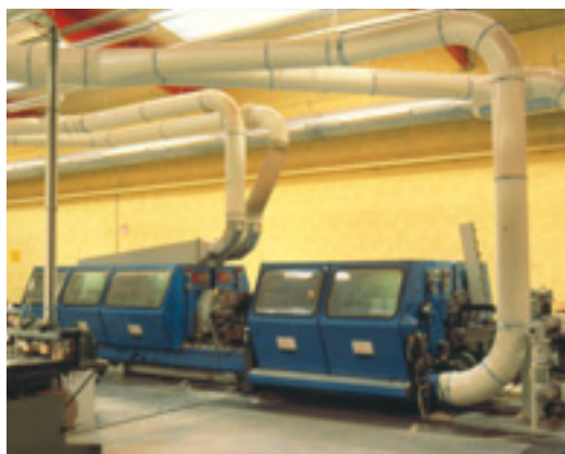
Photo 5.8. Assainissement par dispositifs de captage enveloppant.
