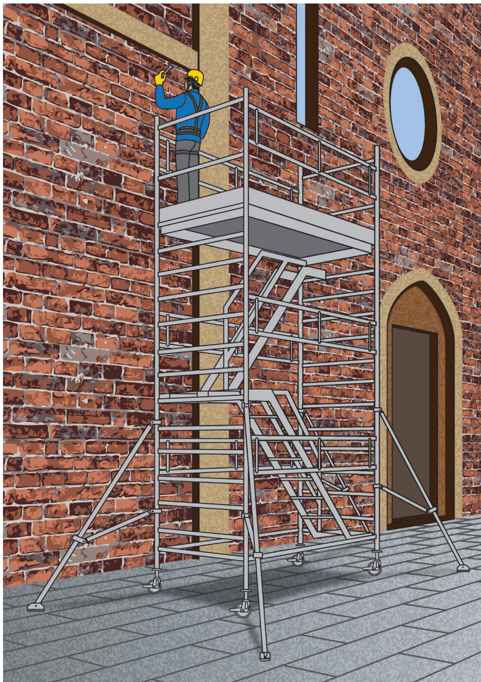
Figura 1 - Trabattello con scala a gradini
