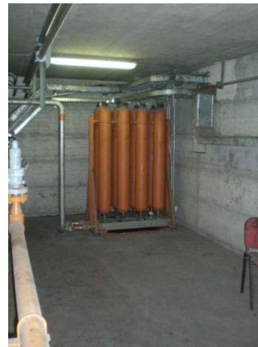
**LOCALE TECNICO (centrale idraulica, con accumulatori azoto)**
