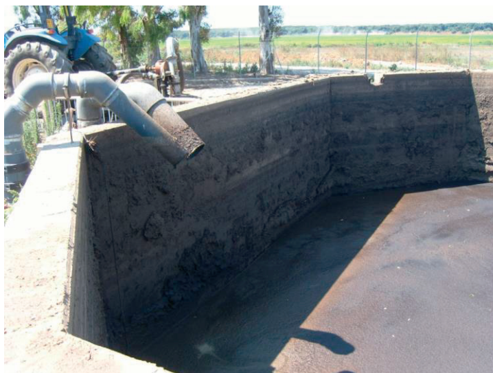
Figura 8 - Vasca di stoccaggio del digestato
