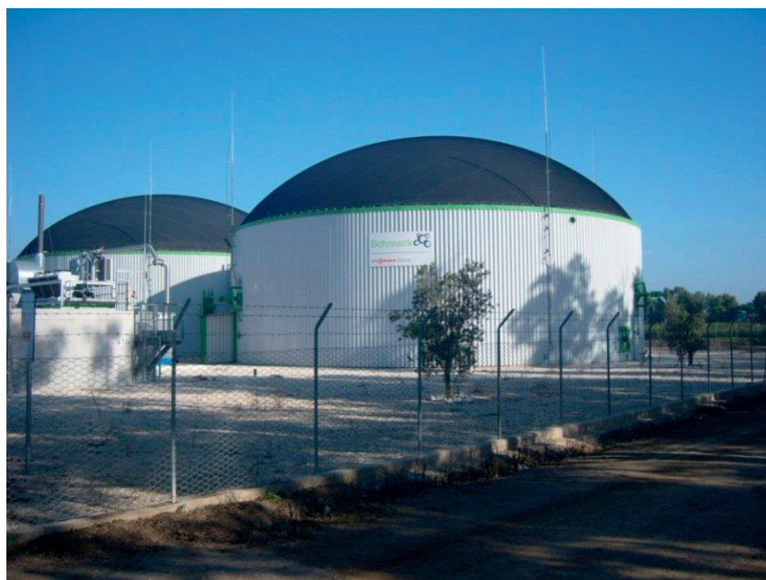
Figura 6 - I digestori anaerobici dell'impianto di Maccarese
