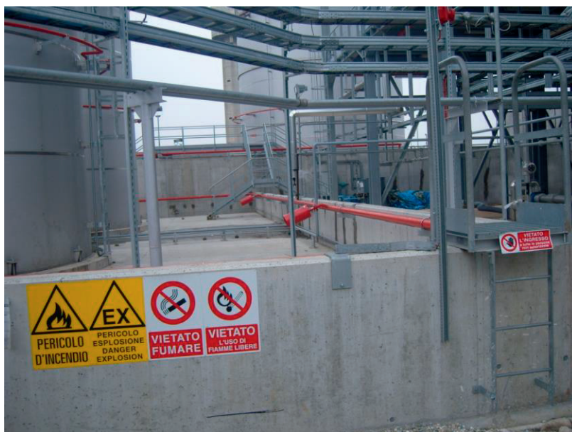
Figura 18 - Sistema di immissione di liquido schiumogeno nel bacino contenente i serbatoi di stoccaggio di bioetanolo
