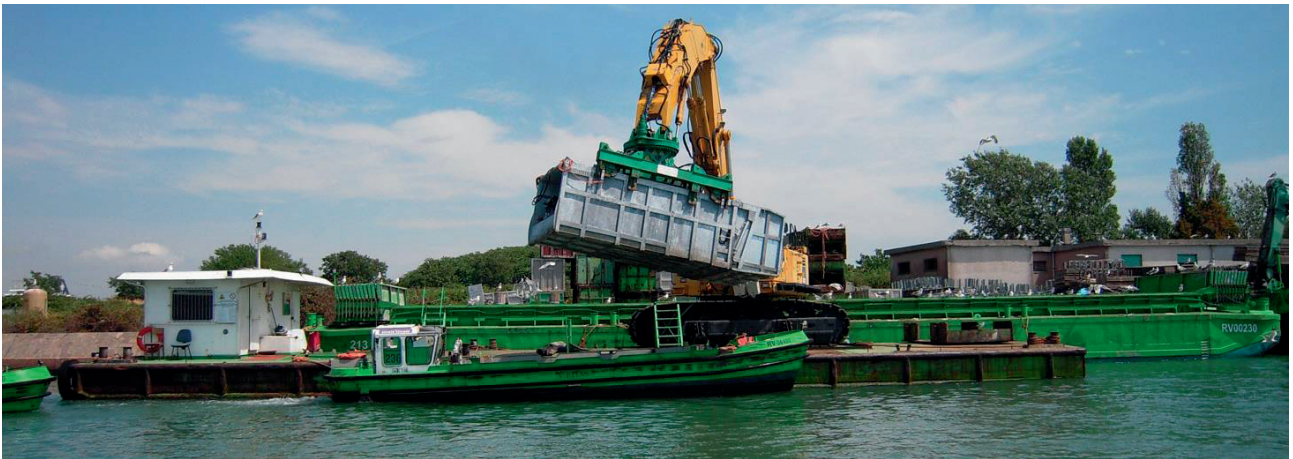
Fig. 6 - Scarico della chiatta (Fonte: www.veritas.it )
