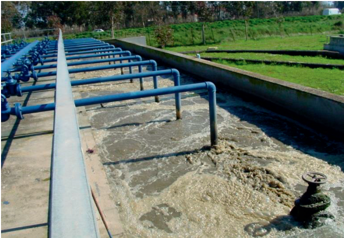
Fig. 23 - Bacino di ossidazione con diffusori sommersi
