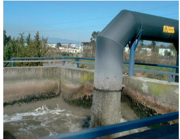
Fig. 24 - Getto in vasca di sedimentazione
