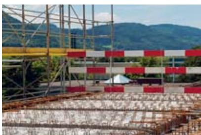
**2** Preassemblare la protezione laterale.
