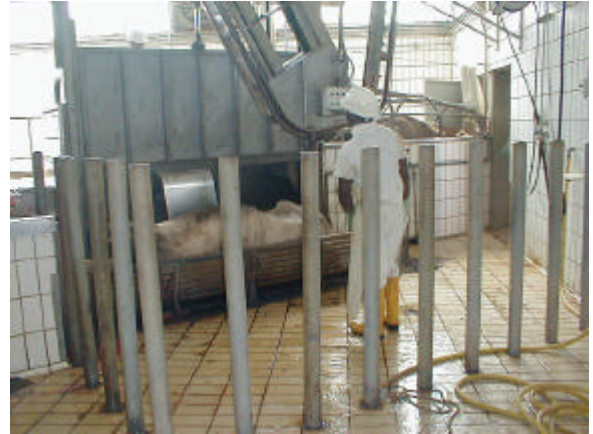
Foto n. 4/B: elementi verticali di protezione
