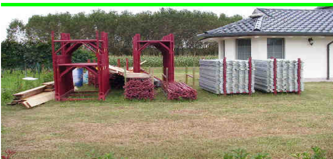
Fig.9 Deposito ponteggio a telai prefabbricati
