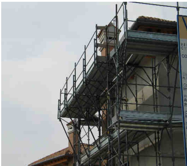
Figura 11 – Sbalzo per lavori su lina
