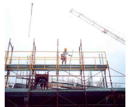
posa correnti parapetto
