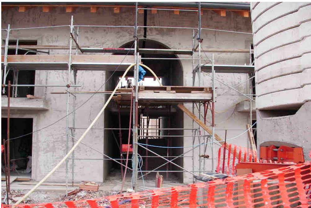
Figura 10 - al centro, piazzola di carico posta tra il ponteggio
