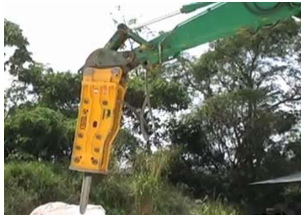
Escavatore : braccio con martello
