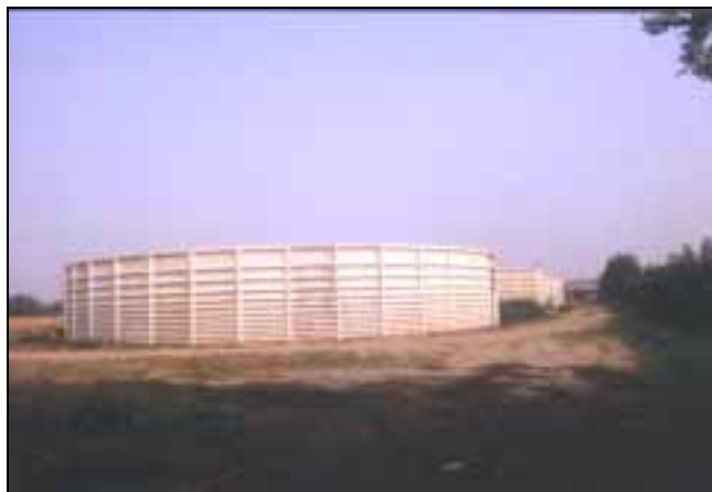
Figura 73 – Vasca di stoccaggio realizzata con elementi prefabbricati
