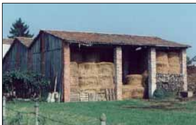
Figura 26 – Deposito per foraggio realizzato mediante riconversione di vecchia struttura
