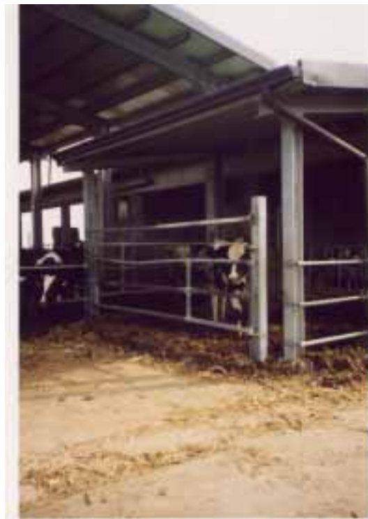
Figura 6 – Esempio di passaggio uomo inaccessibile da parte degli animali
