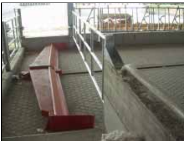
Figura 67 – Raschiatore a ribaltina nella zona di riposo
