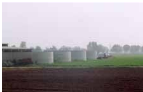
Figura 72 – Vasche realizzate in c.a. in opera
