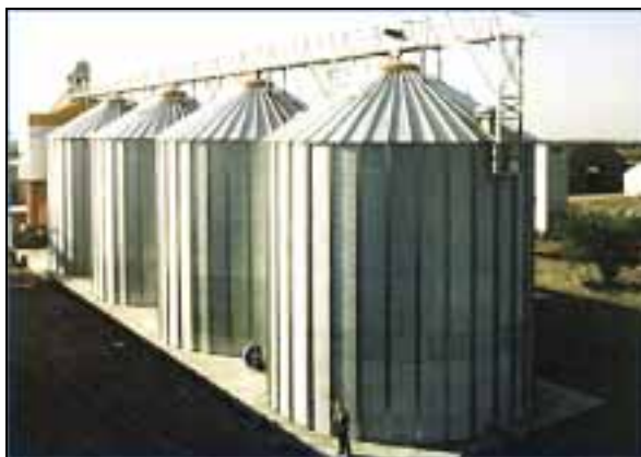
Figura 48 – Silo verticali in lamiera ondulata
