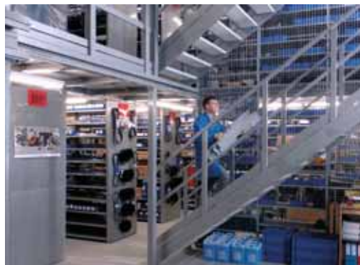
8 Accesso tramite scala fissa (niente scala a pioli).
