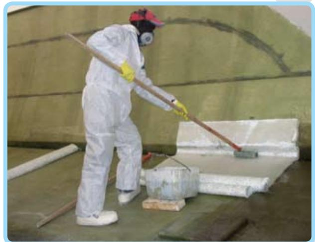
Figura 9: Resinatura con rullo a manico lungo.
