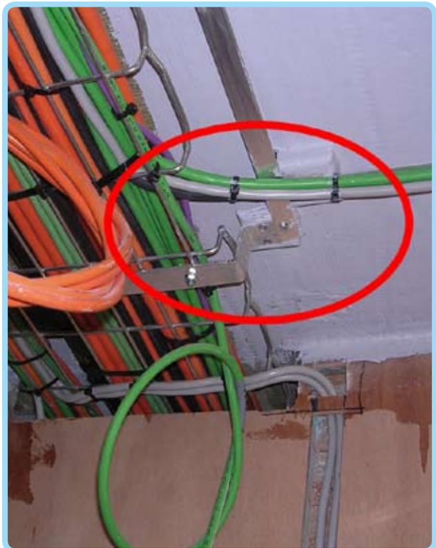
Figure 2 e 3: Impianti elettrici: particolare del supporto in legno per la canaletta affogato nella vetroresina.
