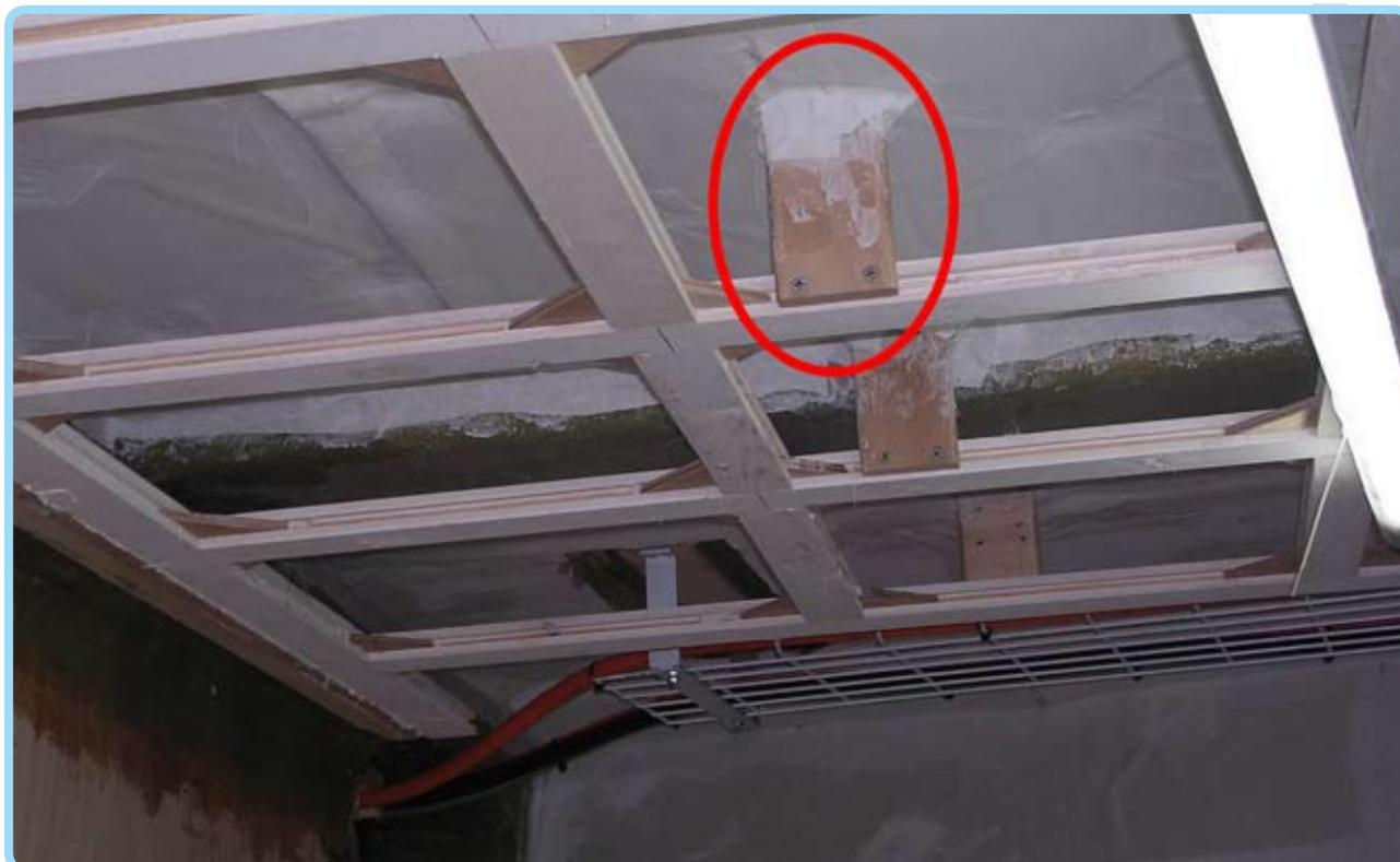
Figura 6: Soffitto locale interno dell'imbarcazione: particolare della fase di imbonaggio.
