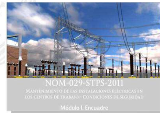
NOM-029 Mantenimiento de instalaciones eléctricas
