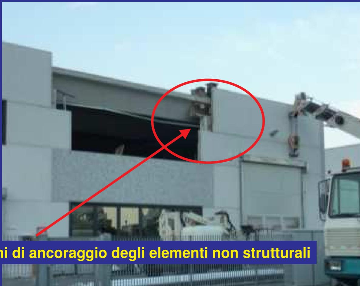
I sistemi di ancoraggio degli elementi non strutturali
