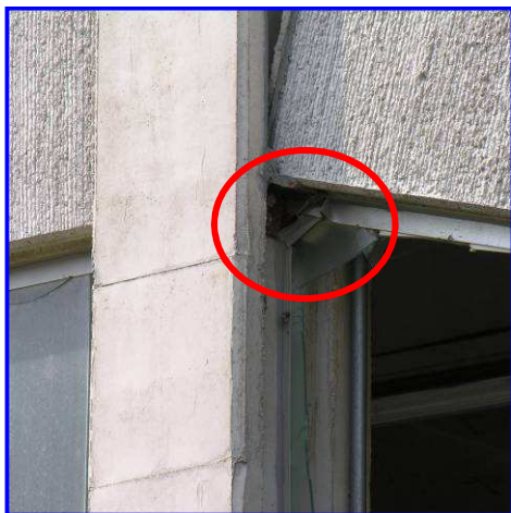
Particolari connessione pannello-pilastro
