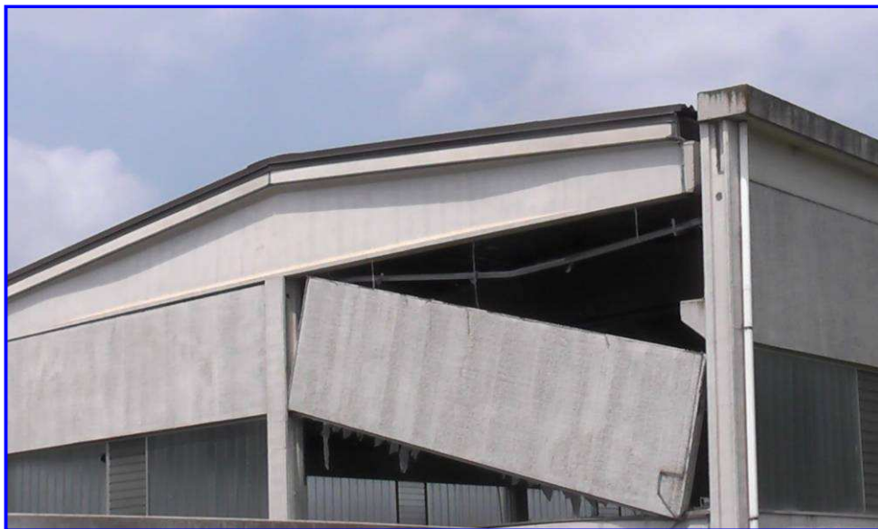
Particolari connessione pannello-pilastro
