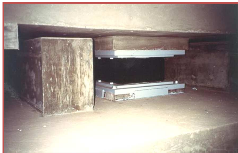
molla e sistema smorzante fluidodinamico
