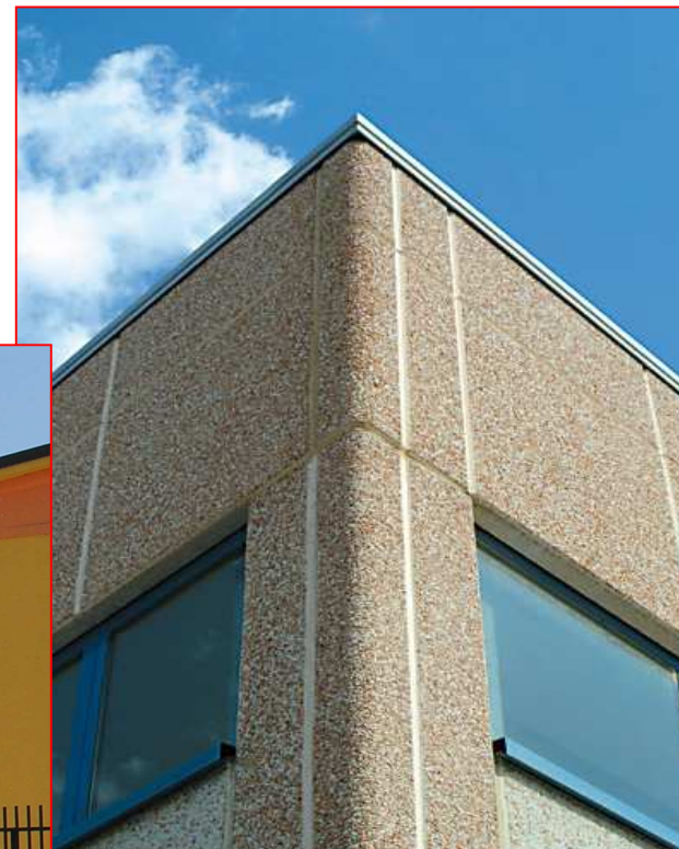
Pannelli prefabbricati orizzontali
