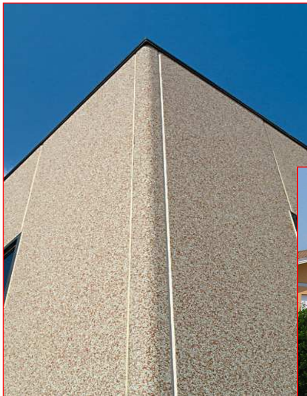
Pannelli prefabbricati orizzontali
