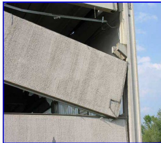
Particolari connessione pannello-pilastro
