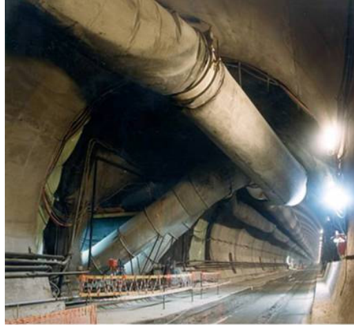
Linea Bologna - Firenze Galleria Sadurano
