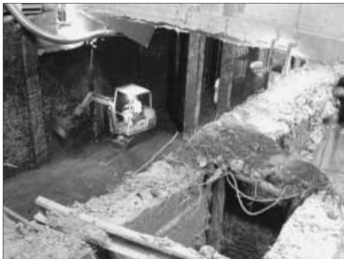
Figura 68: Pulizia interno vasca
