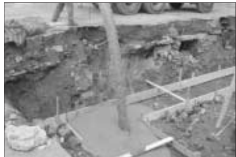
Figura 5: Colata di cemento per il basamento
