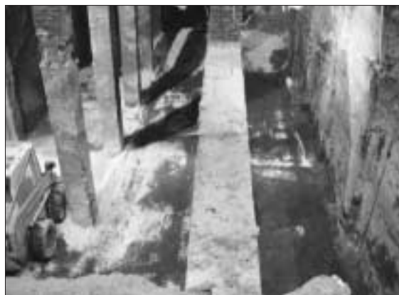
Figura 65: Trasporto dei catrami prelevati sul fondo della vasca verso l'apertura
