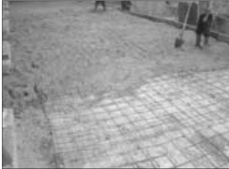
Figura 17: Realizzazione della pavimentazione
