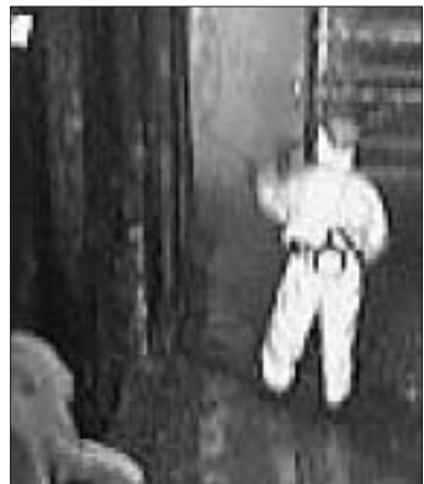
Figura 63: Particolare della pulizia con lance ad acqua
