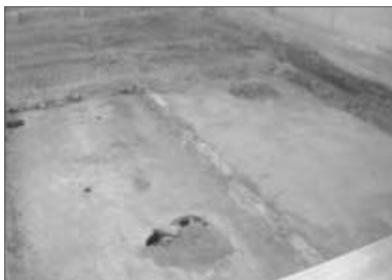
Figura 27: Soletta di copertura delle vasche in cemento
