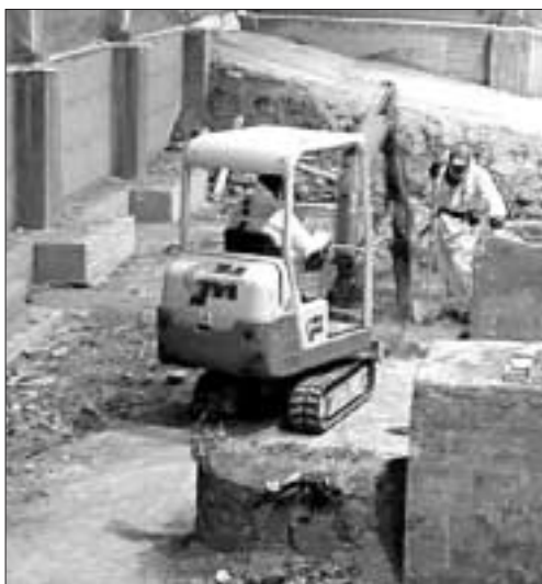
Figura 59: Rottura della soletta
