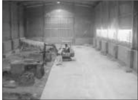
Figura 18: Lavorazioni sul basamento
