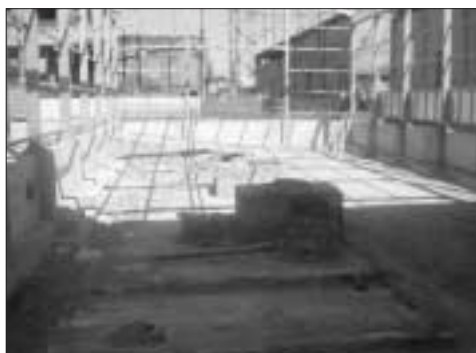
Figura 9: Struttura a sostegno del capannone
