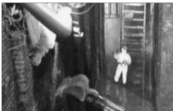
Figura 40: Lavaggio delle pareti
