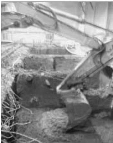
Figura 55: Addensamento del catrame mescolato alla segatura
