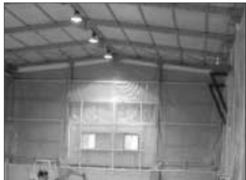
Figura 20: Vista della cabina di comando dall'interno del capannone
