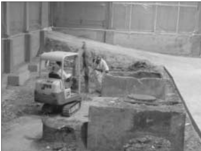
Figura 51: Rimozione della soletta
