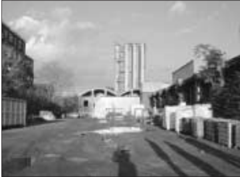
Figura 2: Area di cantiere
