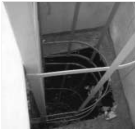
Figura 26: Scale a servizio delle vie di fuga
