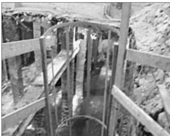
Figura 35: Scala di accesso ed emergenza
