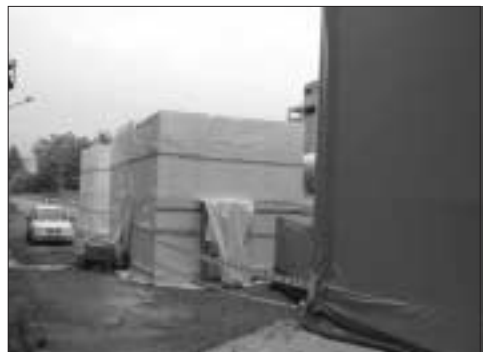
Figura 25: Confinamento delle vie di fuga
