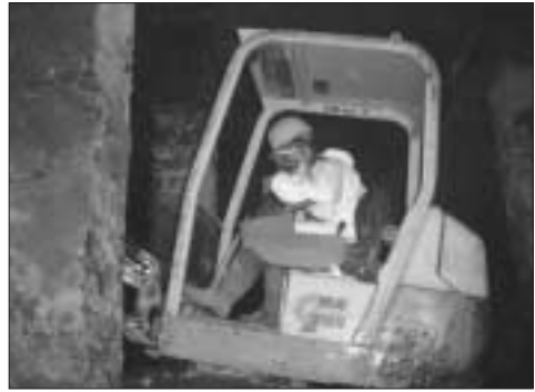
Figura 37: Lavorazione all'interno della vasca
