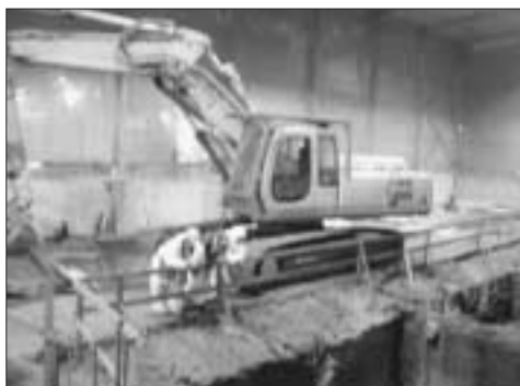
Figura 28: Parapettatura delle vasche
