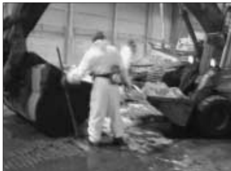
Figura 53: Carico della segatura per mescolarla ai catrami
