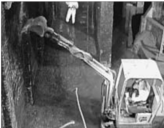
Figura 62: Raschiatura delle apreti
