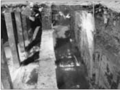
Figura 36: Interno della vasca lato nord
