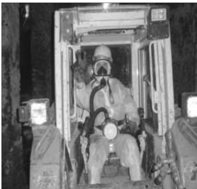
Figura 74: DPI indossati nelle lavorazioni all'interno delle vasche
