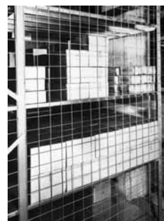
Figura 5: scaffalatura a ripiani provvista di traforato metallico contro la caduta accidentale della merce.
