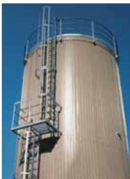
Figura 23 Scala fissa a pioli con gabbia di protezione. Lungo il perimetro del tetto, in corrispondenza della zona di accesso, è montato un parapetto di protezione.
