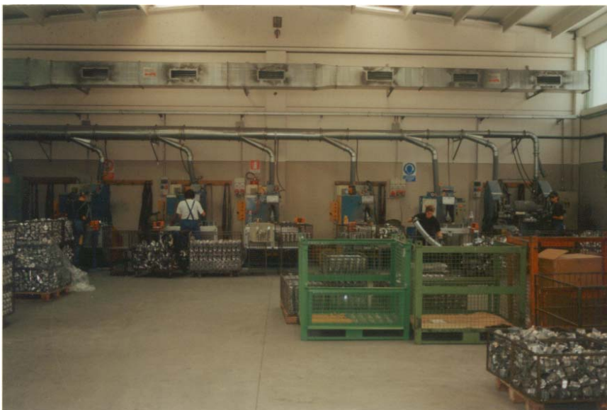
Fig. 2 Interno di uno stabilimento
