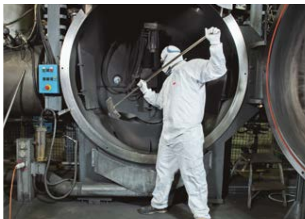
Figura 4 La pulizia delle cabine di spruzzatura comporta un pericolo elevato a causa delle polveri di spruzzatura.
