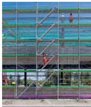
Regola 9 Creare luoghi di lavoro e accessi sicuri.
