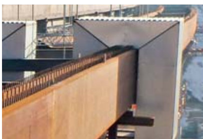
2 Struttura ad involucro per saldature. Con qualità per la qualità: accessi sicuri, luoghi di lavoro sicuri.
