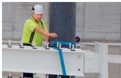
3 Mettere in sicurezza i componenti per evitare che si ribaltino.
