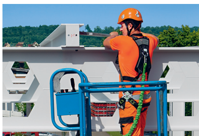
2 Lavoro di montaggio con piattaforma di lavoro elevabile: efficiente, sicuro ed ergonomico.
