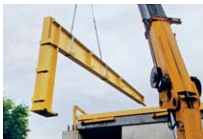
2 Imbracare correttamente i carichi asimmetrici.
