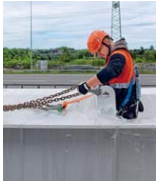
Regola 2 Utilizzare i punti di ancoraggio previsti.
