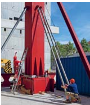
Regola 7 Stabilizzare i componenti.
