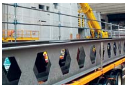
2 Preassemblare la protezione laterale già in fabbrica oppure sul luogo di scarico.
