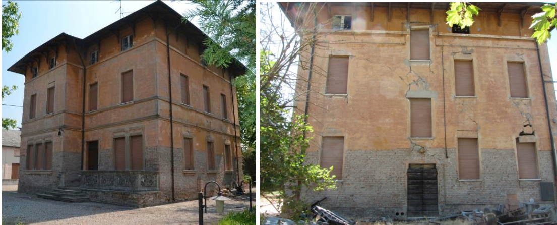
(a) (b) Fig. B-1 Vista dei prospetti Sud e Ovest (a) e del prospetto Est (b).
