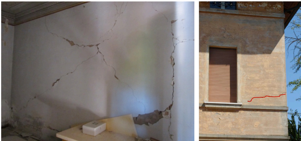
(a) (b) Fig. B-3 Lesioni nei maschi: (a) rottura a taglio in una parete interna; (b) pressoflessione in un maschio poco caricato al secondo piano di una parete perimetrale.
