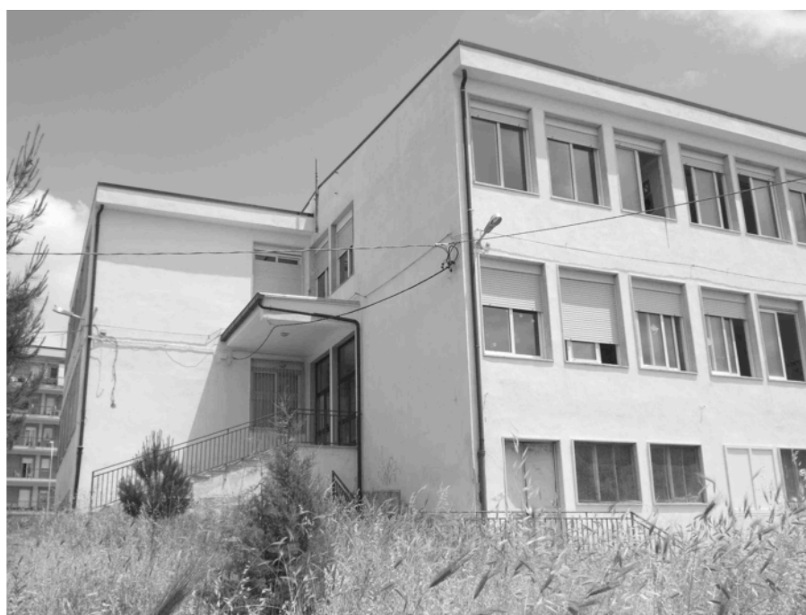
Fig. C-2 Foto prospetto NO.
