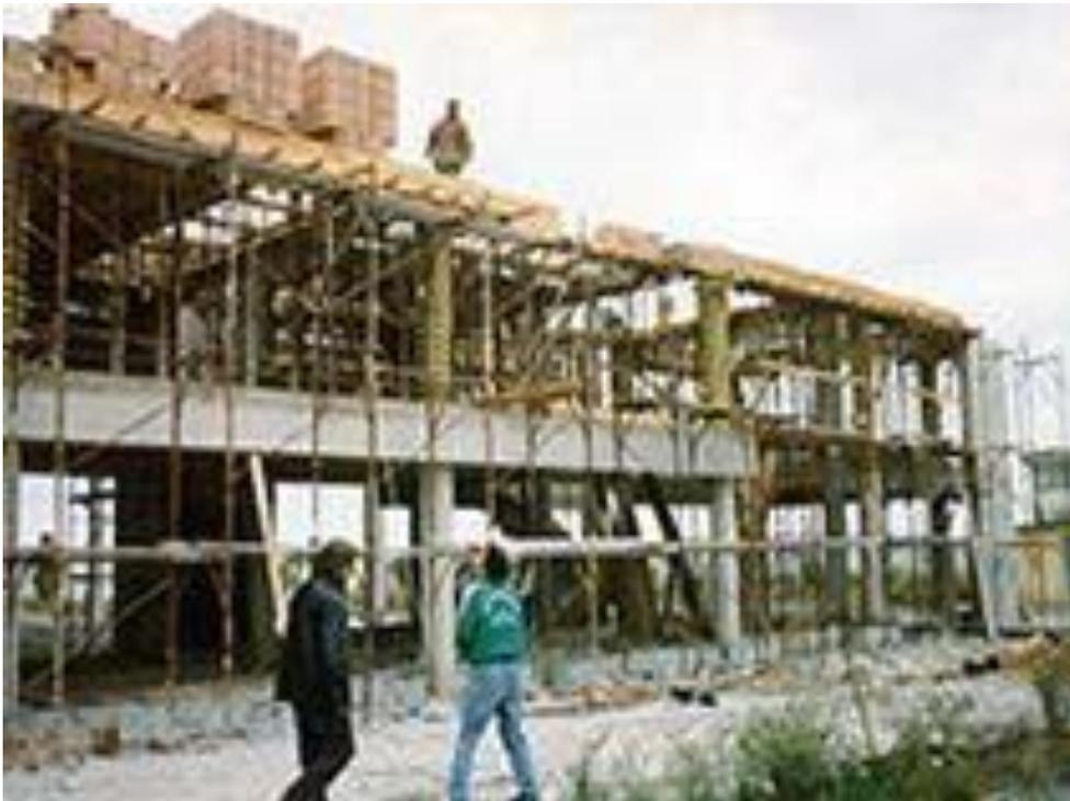
**Siamo di fronte ad un tipico e purtroppo assai diffuso in EDILIZIA rischio di CADUTA dall'ALTO determinato come in questa foto dalla copertura piana sprovvista della necessaria ed obbligatoria PROTEZIONE costituita da idoneo parapetto**
