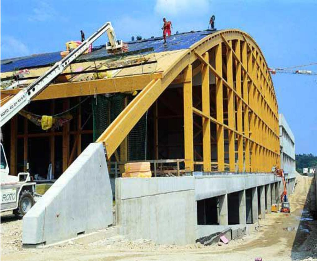
**Questa FOTO dimostra in maniera inequivocabile il fattore di RISCHIO a carico degli addetti i quali sono privi della necessaria “..... CINTURA di SICUREZZA con bretelle a fasce gluteali.... collegate ad una idonea FUNE di trattenuta....che limiti la caduta a non più di 1.5 metri..... mediante un gancio di sicurezza..... prevedendo dispositivi ad assorbimento di energia dissipatori.....”.**
