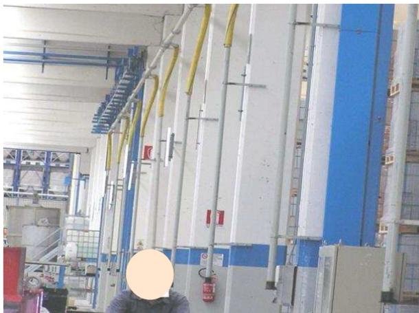
Sistema di tubazioni per la pulitura delle polveri ad "alta velocità".
