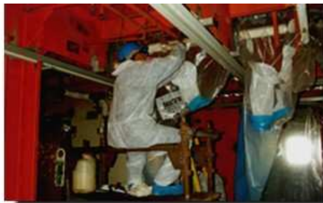
Figura 53 - Posizionamento del Glove-Bag
