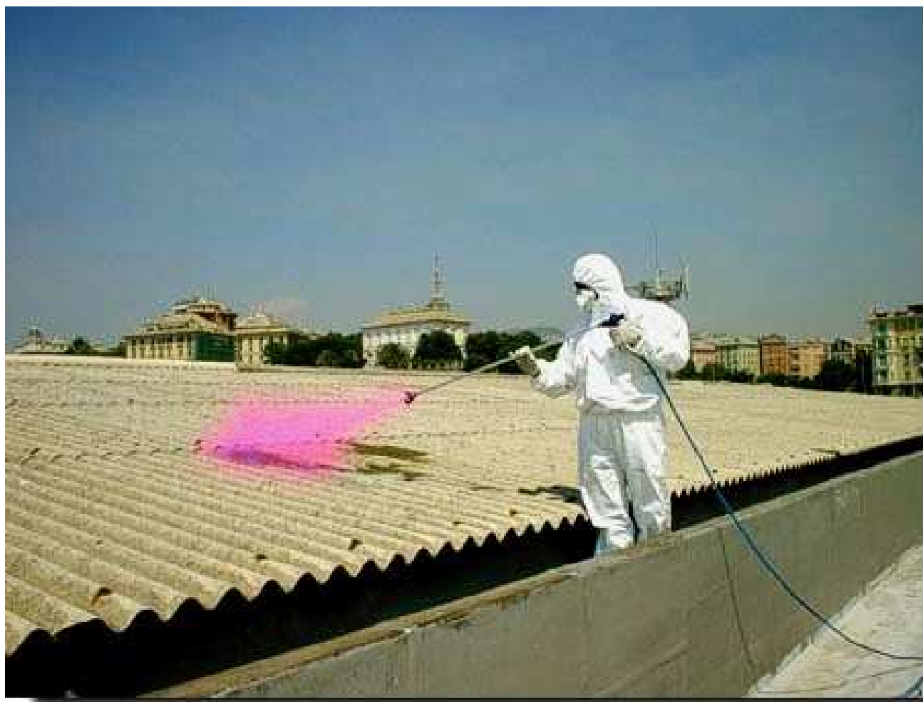
Figura 60 - Bagnatura del cemento-amianto
