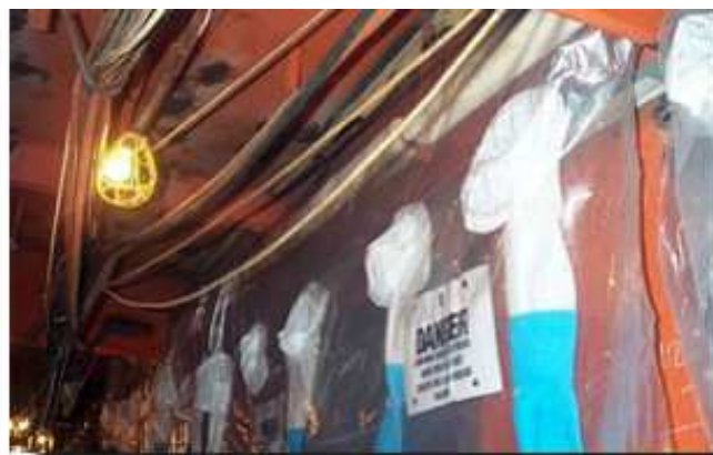
Figura 51 - Isolamento della zona con Glove-Bag
