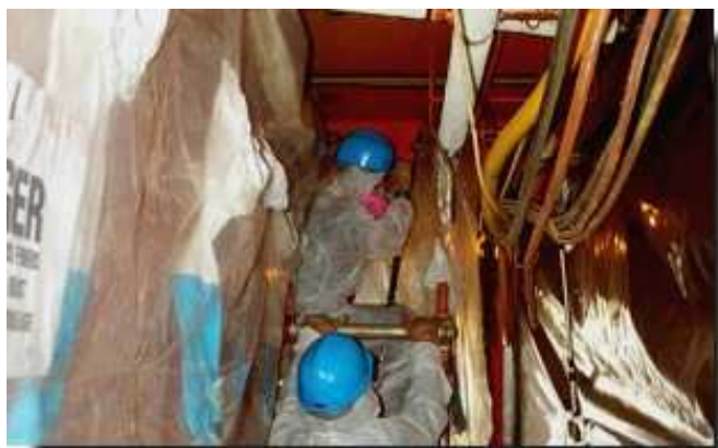
Figura 50 - Installazione opere provvisorie
