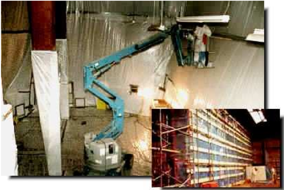
Figura 57 - Installazione delle opere provvisionali
