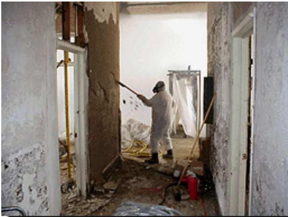
Figura 26 - Rimozione rivestimento dopo il trattamento
