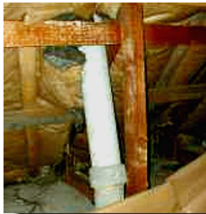
Figura 6 Canne fumarie in cemento-amianto
