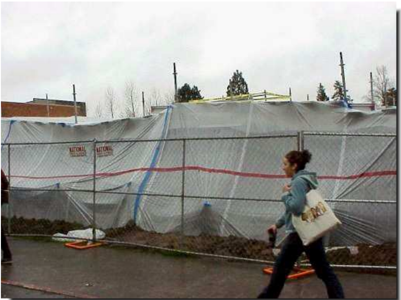
Figura 19 - Cantiere di lavoro
