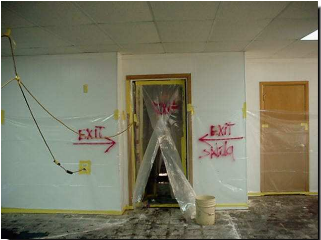
Figura 28 - Delimitazione dell'area di lavoro: uscita
