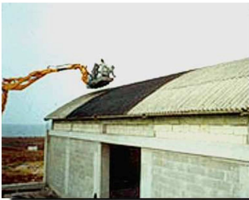
Figura 61 - Posa della sovracopertura
