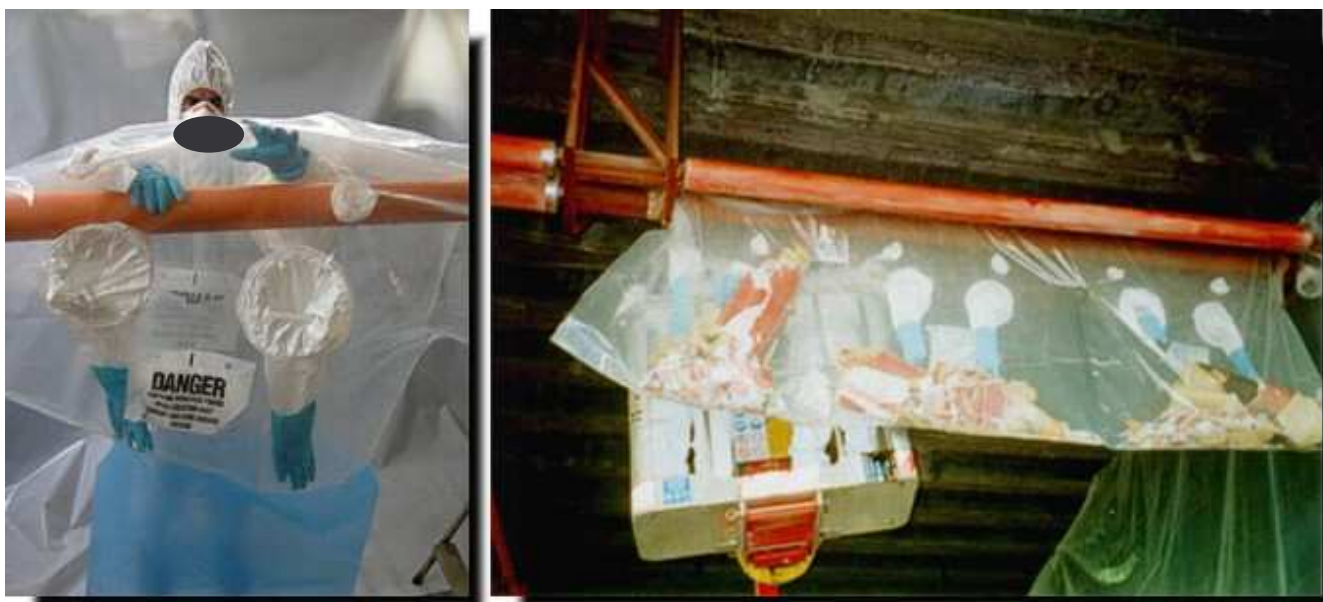
Figura 49 - Tecnica del Glove-Bag
