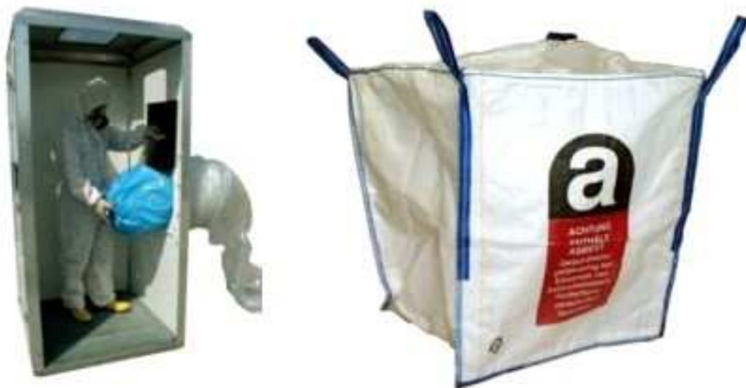
Figura 46 - locale di imballaggio dei sacchi di rifiuto in un secondo contenitore pulito
