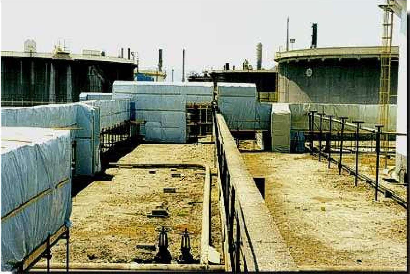
Figura 63 - Predisposizione area di cantiere
