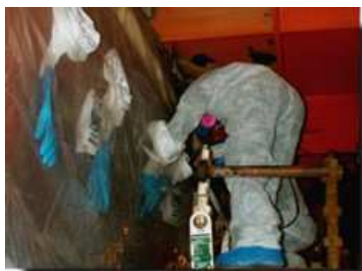
Figura 54 - Rimozione del materiale contaminato
