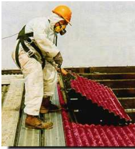
Figura 15 – Rimozione lastre in eternit
