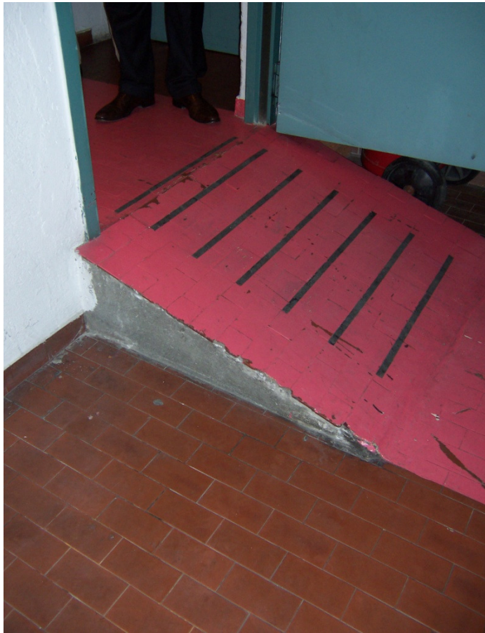
Rampa di accesso di servizio utilizzata come passaggio merci.
