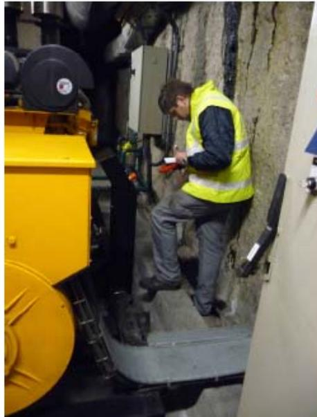
**Figure 2 : Maintenance préventive d'un groupe électrogène (local technique)**
