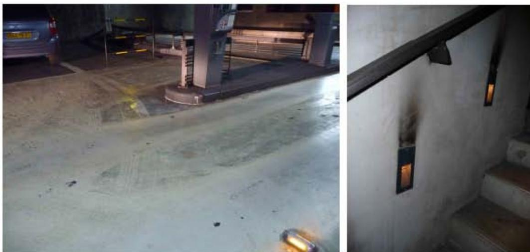
**Figure 7 : Poussière accumulée sur le sol d'un parc de stationnement (à gauche) et au dessus des blocs d'éclairage dans des escaliers d'accès (à droite)**
