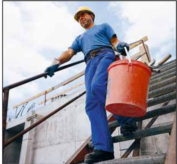
Figura 18 Scala libera. L'operatore può tenersi comodamente al corrimano.
