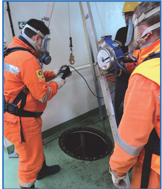
▲ Figura 7 - Prima di accedere a un luogo confinato deve essere rilevata la qualità dell'aria presente utilizzando un gas detector
