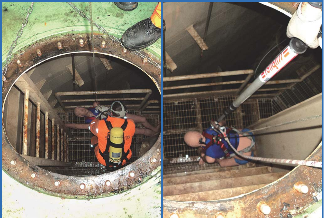
▲ Figura 3 - Sistema di recupero infortunato o colpito da malore all'interno di un luogo confinato: treppiede con sistema recupero, asta di recupero
