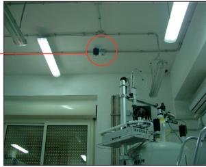
**Figura 31 - Sensore ossigeno posto a soffitto**
