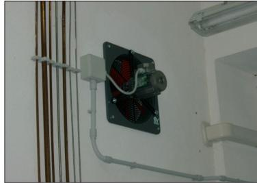
**Figura 33 - Ventilatore alto per l'Elio**
