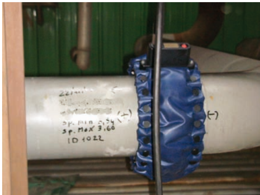
Fig. G1 dettaglio area di applicazione del trasduttore ad onde guidate
