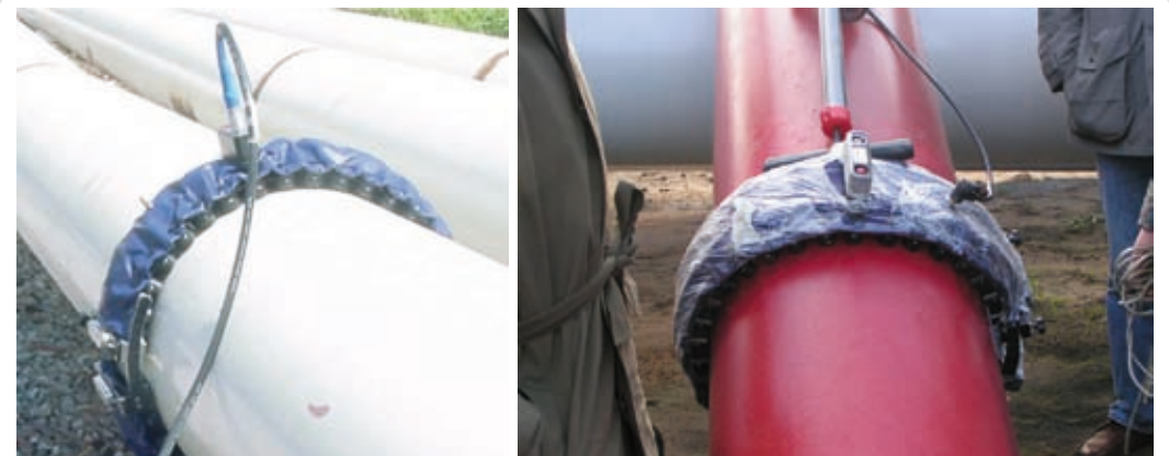
Fig. 10 - Sistemi di eccitazione a fascia pneumatica.
