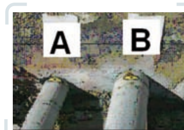
Fig. D7 - Tipiche penetrazioni in parete del tipo "ad incastro" in impianto petrolchimico.
