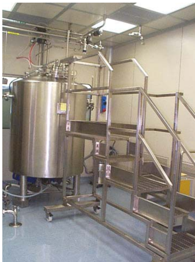
Fig. 8. Serbatoi di stoccaggio emulsione.
