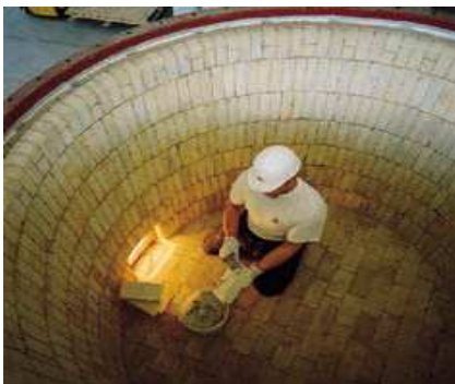
Fig. 1 - Rifacimento refrattario.
