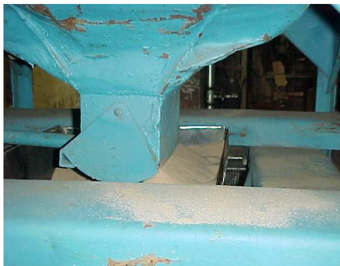
Foto 3 – Scarico di sabbia da tramoggia
