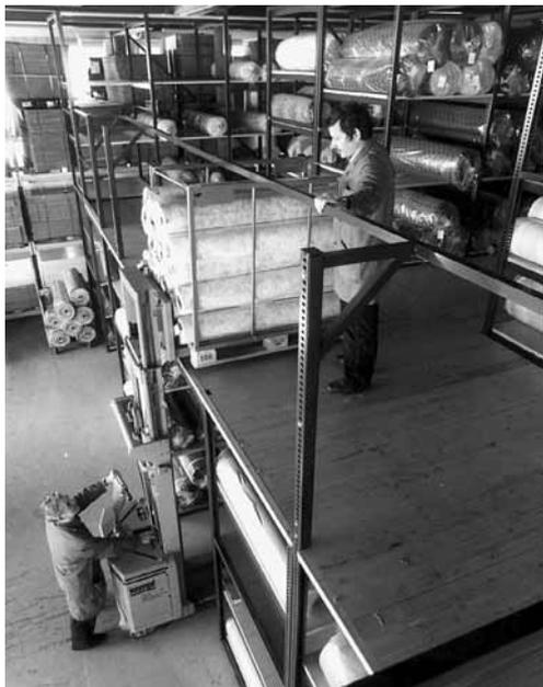
Figura 7: in caso di merci di piccole dimensioni (fino ad un metro di altezza) la paletta può essere fatta passare sotto la ringhiera. La ringhiera deve essere alta al massimo 1,2 m e deve essere posizionata almeno a 0,5 m dal bordo del ripiano. In questa zona mancano infatti il corrente intermedio e la fascia fermapiede.
