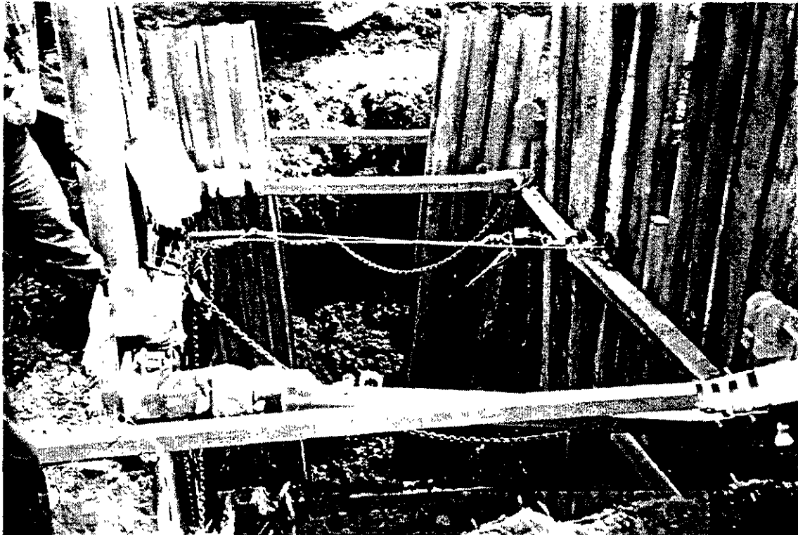
Photo 29 - Glissement d'une paroi de silt
