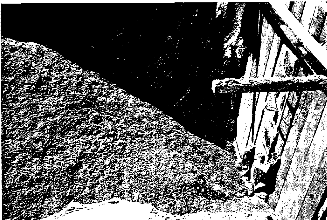
Photo 23 - Déversement du sable sur la face instrumentée du VM2
