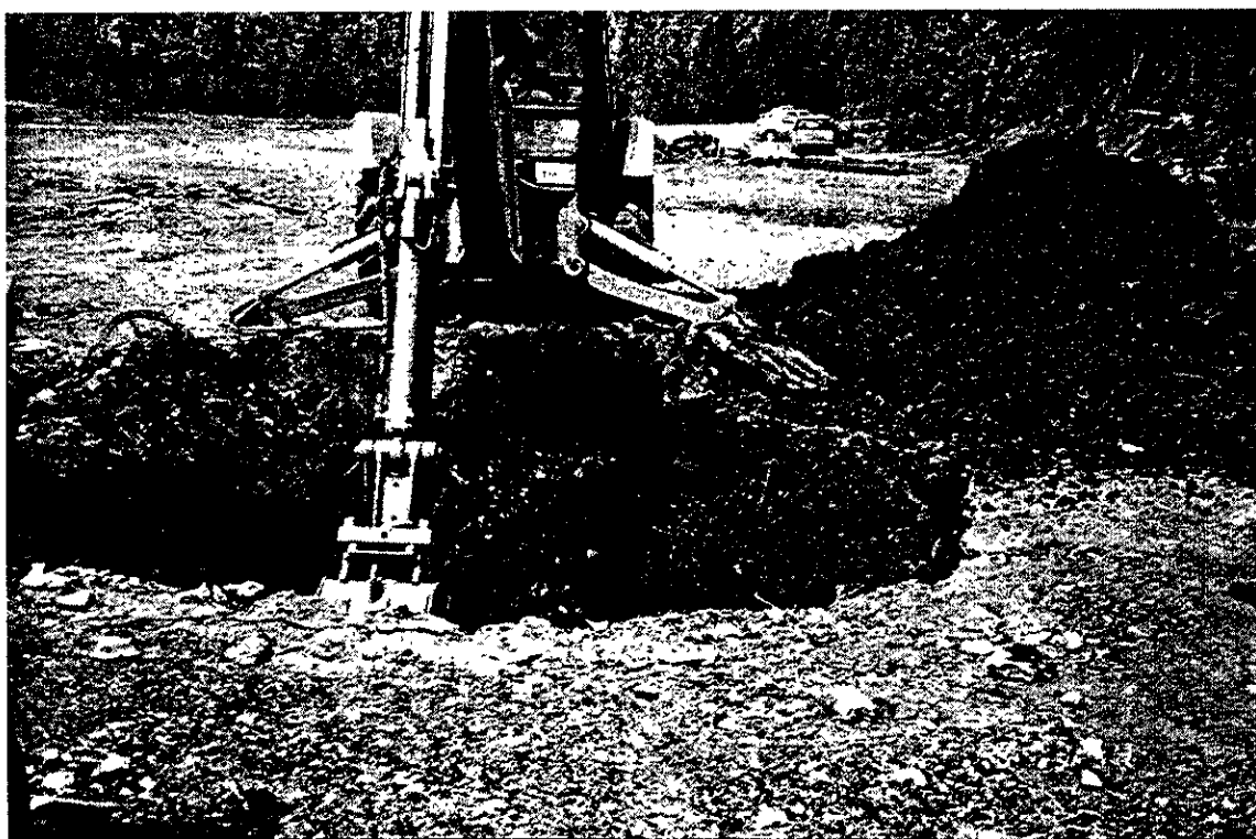
Photo 4 - Excavation du puits d'essai (Carrière Francon)
