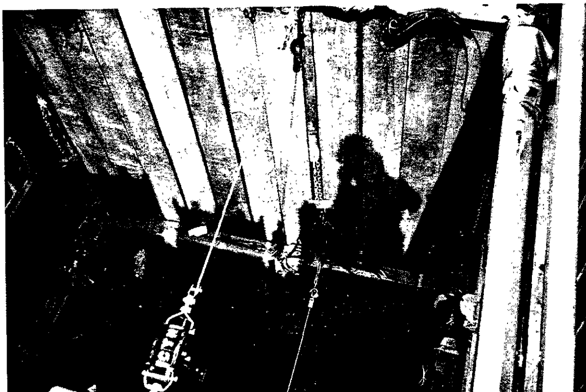
Photo 11 - Vue du blindage en bois
