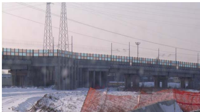
Dicembre 2004 VI 40 - Viadotto ferrovie nord Milano. Opere civili completate. Lavori di linea di contatto
