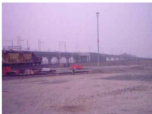
Dicembre 2004 GA W1 – Galleria artificiale interconnessione vercellese ovest con linea storica. Vista d'insieme
