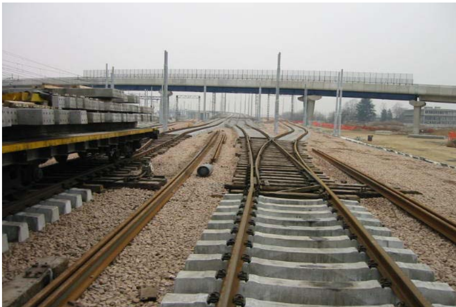
Dicembre 2004 SF 01 - Armamento da PK 0+000 a PK 1+000. Posa deviatoio
