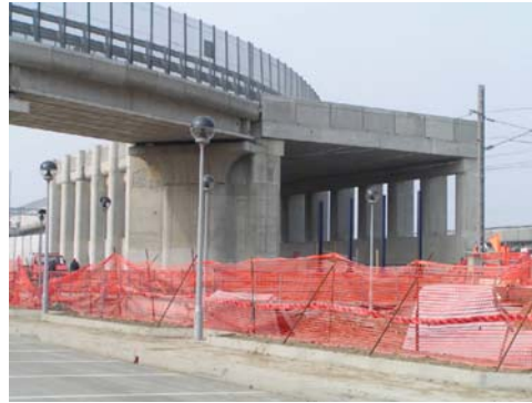
Dicembre 2004 GA 01 – Galleria artificiale. Svincolo Settimo uscita da Torino. Galleria completata
