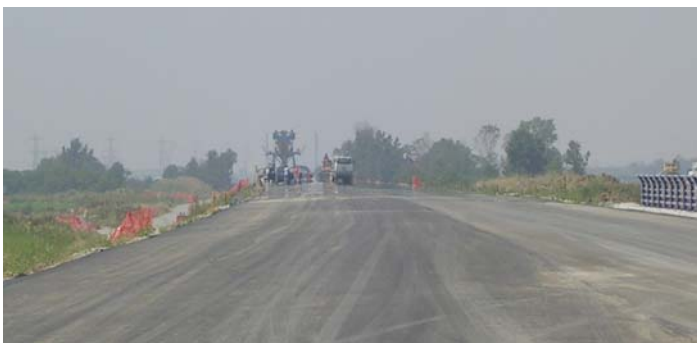
Luglio 2004 RI 27 – Rilevato da PK 46+400 a PK 47+890. Posa sub-ballast
