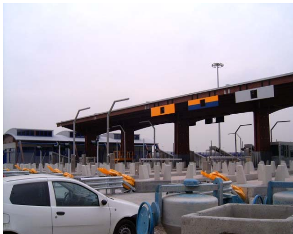
Dicembre 2004 BS 06 – Stazione autostradale di Agognate. Lavori di completamento
