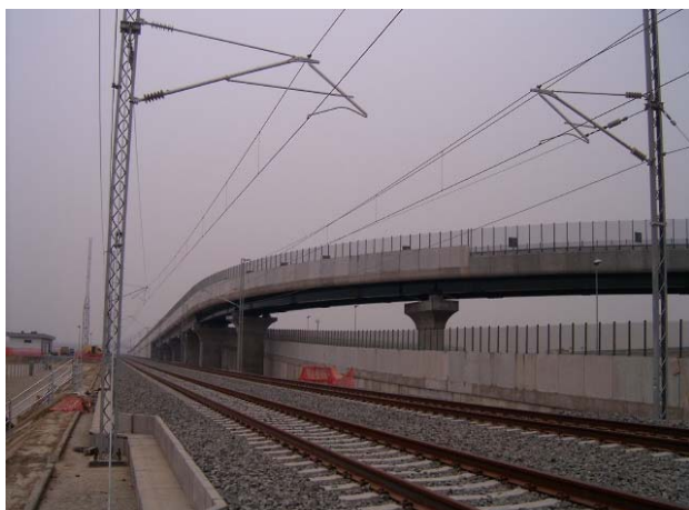
Dicembre 2004 IV 47 – Sovrappasso su A4 rampa Torino-Balocco. Opera completata
