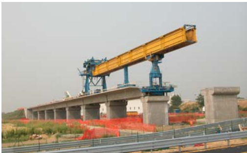
Luglio 2004 VI 17 - Viadotto Santhià. Impalcati tipologia monocassone varati da 1 a 7. Carro varo
