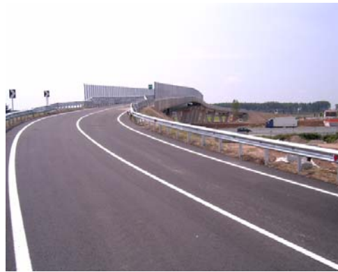
Dicembre 2004 IV 69 - Sovrappasso su A4 e AC strada comunale Gargarengo tipo VI. Viadotto consegnato
