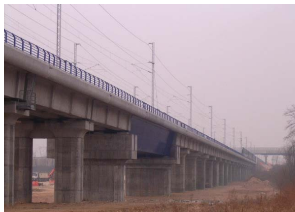
Dicembre 2004 VI 25 – Viadotto Rovasenda. Vista lato sud
