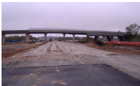
Luglio 2004 IV 38 – Sovrappasso su A4 e AC S.P. San Damiano tipo VI. Fase varo velette
