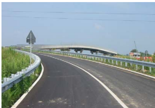
Luglio 2004 IV 34 – Sovrappasso su A4 e AC strada comunale della Bertella tipo VI. Strada completata
