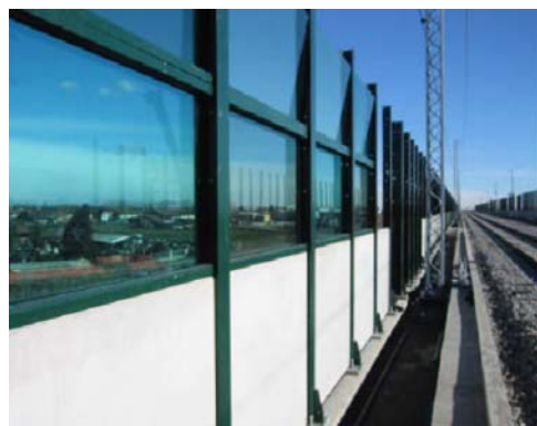
Dicembre 2004 VI 11 - Viadotto su FS Chivasso-Aosta. Montaggio pannelli barriere antirumore
