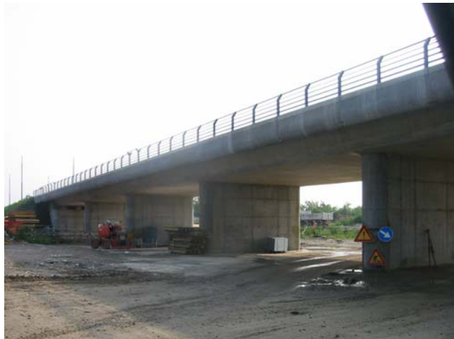
Luglio 2004 VI 40 - Viadotto ferrovie nord Milano. Impalcato completato. Opere civili di completamento
