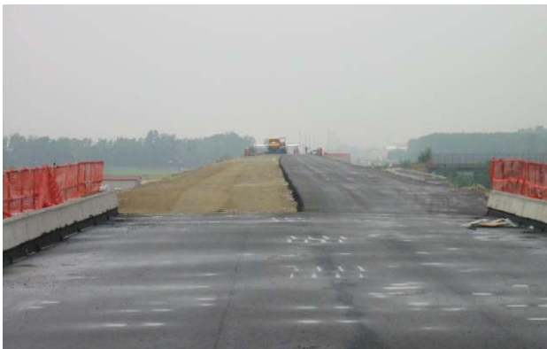
Luglio 2004 RI 09 – Rilevato da PK 8+254 a PK 8+509. Stesura sub-ballast
