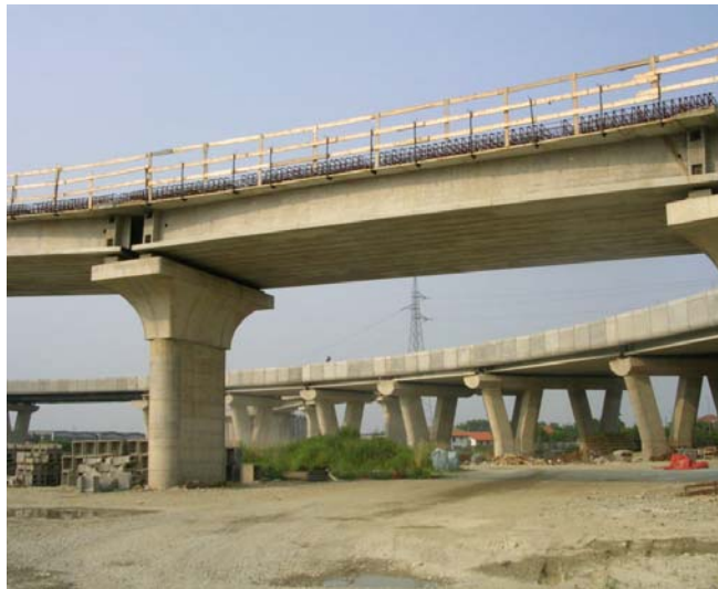
Luglio 2004 IV 03 – Sovrappasso su A4 e AC. Svincolo di Settimo T.se
