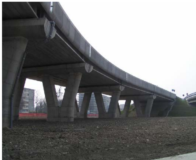
Dicembre 2004 IV 03 – Sovrappasso su A4 e AC. Svincolo di Settimo T.se. Viadotto completato
