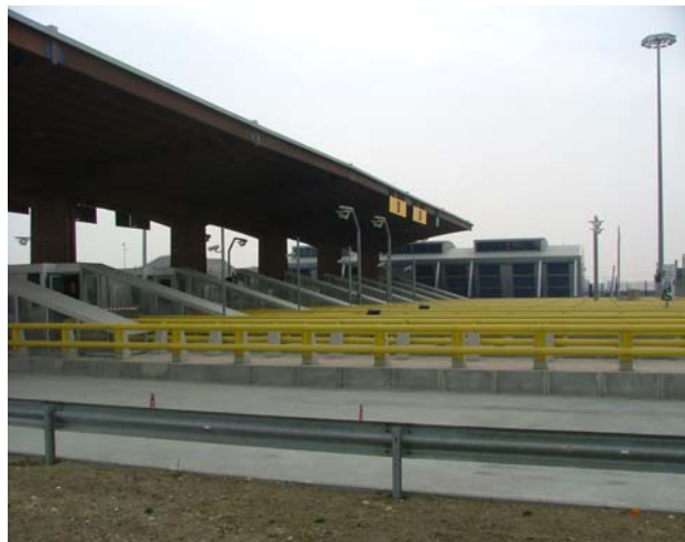
Dicembre 2004 BS 05 – Stazione autostradale di Biandrate. Casello completato
