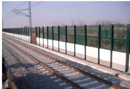
Dicembre 2004 VI 17 - Viadotto Santhià. Opera completata
