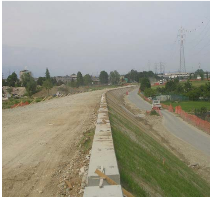
Luglio 2004 RI 02 - Rilevato da PK 1+654 a PK 3+243. Tombini in ultimazione
