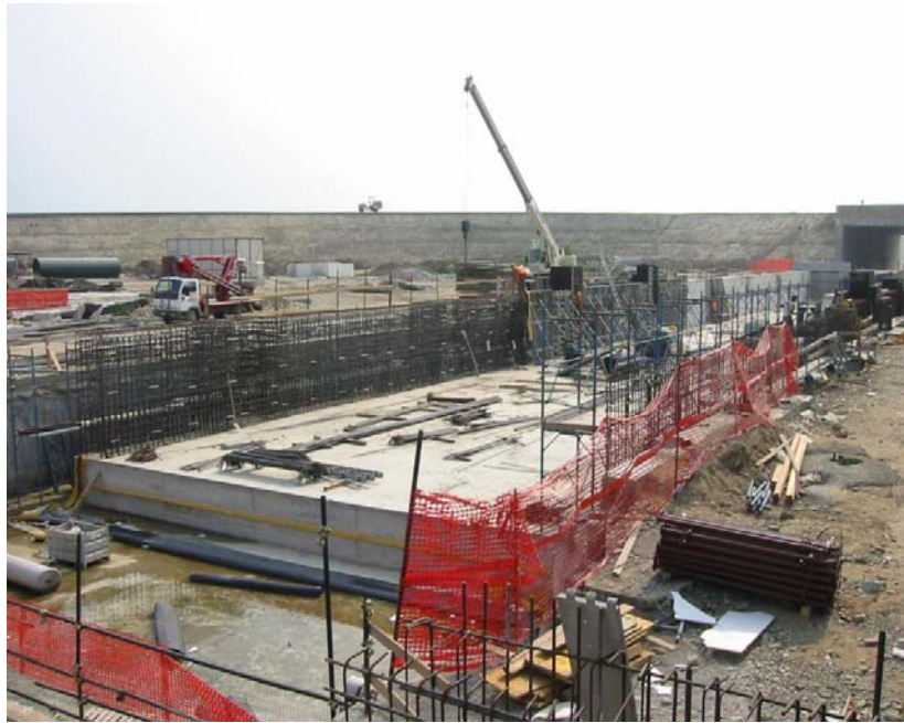
Luglio 2004 TR 06 – Trincea da PK 70+819 a PK 71+016. Fondazione trincea
