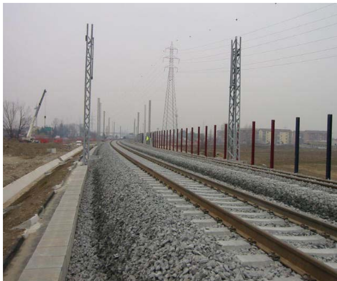
Dicembre 2004 RI 02 - Rilevato da PK 1+654 a PK 3+243. Posa montanti barriere antirumore
