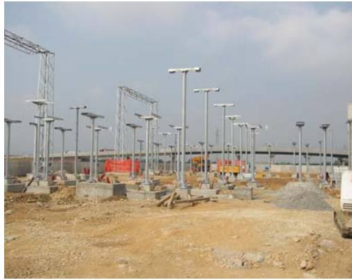
Luglio 2004 FA 06 – Fabbriato e piazzale sotto stazione elettrica di Chivasso
