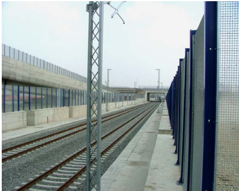
Dicembre 2004 TR 06 – Trincea da PK 70+819 a PK 71+016. Completamento trincea
