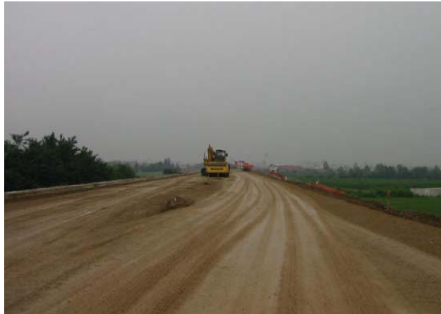
Luglio 2004 RI 14 - Rilevato da PK 13+404 a PK 14+032. Stesura super-compattato
