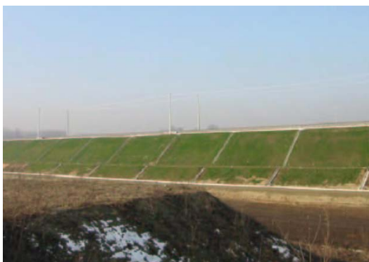
Luglio 2004 RI 08 – Rilevato da PK 7+971 a PK 8+202. Posa pali trazione elettrica
