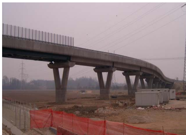
Dicembre 2004 IV 48 – Sovrappasso su A4 e AC S.P. Balocco-Villarboit tipo V. Opera completata
