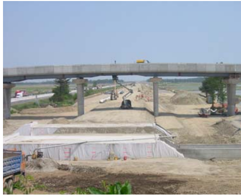
Luglio 2004 IV 69 - Sovrappasso su A4 e AC strada comunale Gargarengo tipo VI. Vista del viadotto dalla linea AC
