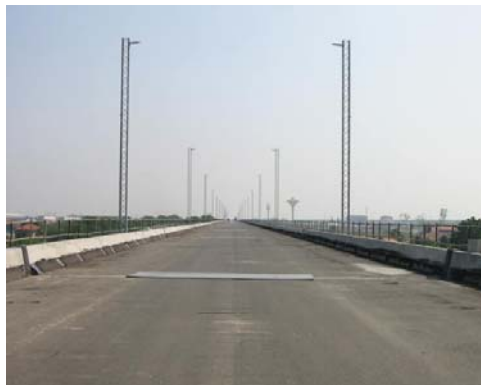
Luglio 2004 VI 11 - Viadotto su FS Chivasso-Aosta. Posa pali trazione elettrica
