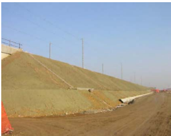
Luglio 2004 RI 09 – Rilevato da PK 8+254 a PK 8+509. Stesura sub-ballast
