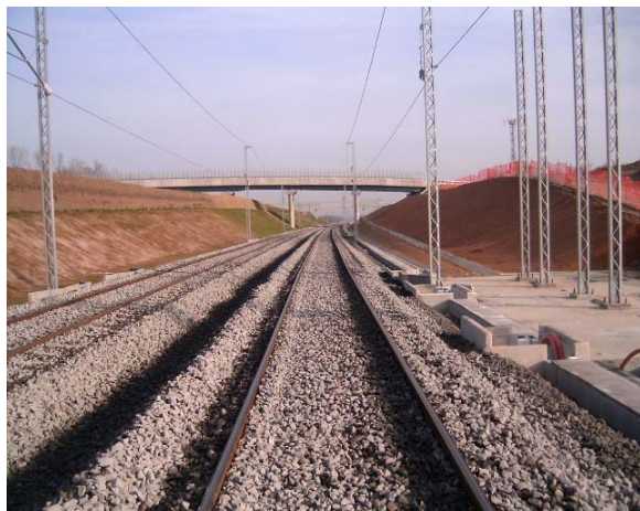
Dicembre 2004 TR 03 – Trincea da PK 48+250 a PK 48+820. Armamento completato
