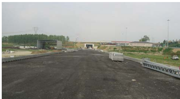
Luglio 2004 RI 21 – Rilevato da PK 23+274 a PK 23+821. Stesura sub-ballast
