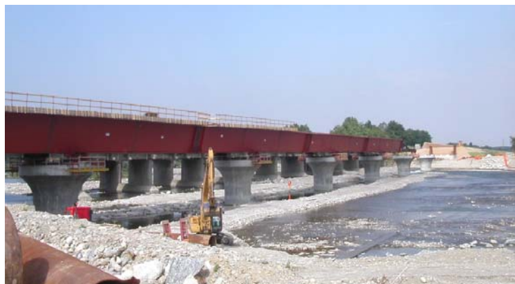
Luglio 2004 VI 28 - Viadotto Sesia. Vista lato sud
