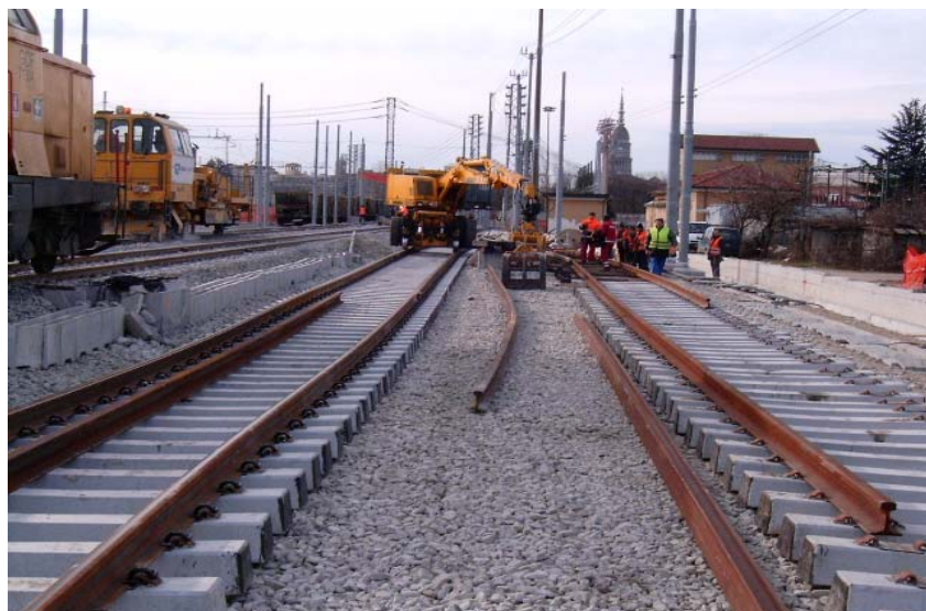
Dicembre 2004 SF Z1 – Sovrastruttura ferroviaria ferrovie nord. Posa binario
