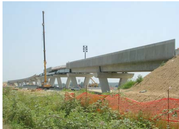
Luglio 2004 IV 38 – Sovrappasso su A4 e AC S.P. San Damiano tipo VI. Fase varo velette
