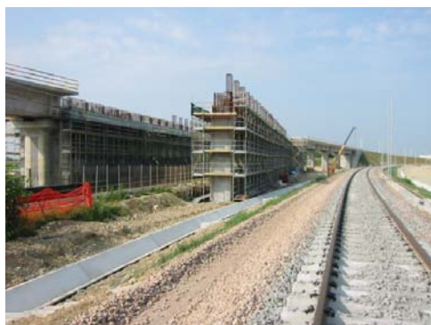
Luglio 2004 GA W1 – Galleria artificiale interconnessione vercellese ovest con linea storica. Casseratura pareti laterali
