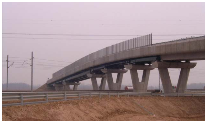
Dicembre 2004 IV 44 – Sovrappasso su A4 e AC strada comunale La Lista-Cascinassa tipo B. Opera completata
