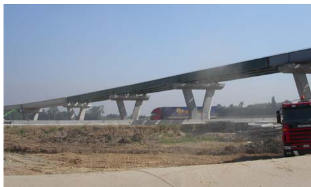
Luglio 2004 IV 48 – Sovrappasso su A4 e AC S.P. Balocco-Villarboit tipo V. Varo travi metalliche
