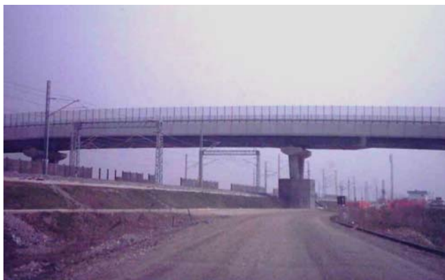
Dicembre 2004 IV 34 – Sovrappasso su A4 e AC strada comunale della Bertella tipo VI Vista laterale
