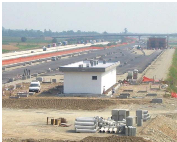
Luglio 2004 RI 24 – Rilevato da PK 32+715 a PK 40+954. Vista d'insieme
