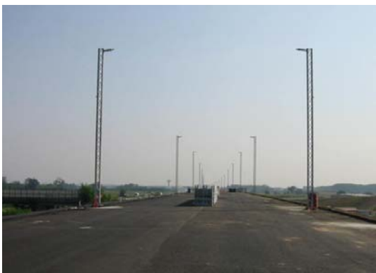
Luglio 2004 RI 08 – Rilevato da PK 7+971 a PK 8+202. Posa pali trazione elettrica
