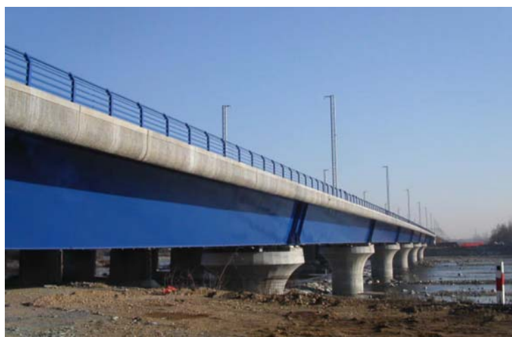
Dicembre 2004 VI 28 - Viadotto Sesia. Completamento verniciatura impalcato metallico
