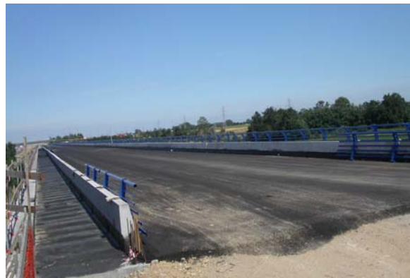
Luglio 2004 VI 25 – Viadotto Rovasenda. Posa sub-ballast
