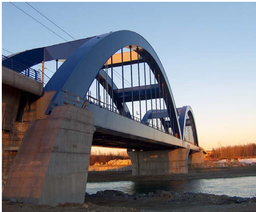
Dicembre 2004 VI 14 - Viadotto Dora Baltea. Opera completata
