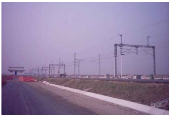
Dicembre 2004 RI 24 – Rilevato da PK 32+715 a PK 40+954. Vista d'insieme
