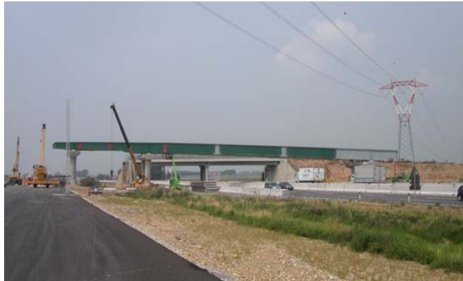
Luglio 2004 IV 44 – Sovrappasso su A4 e AC strada comunale La Lista-Cascinassa tipo B. Varo travi metalliche
