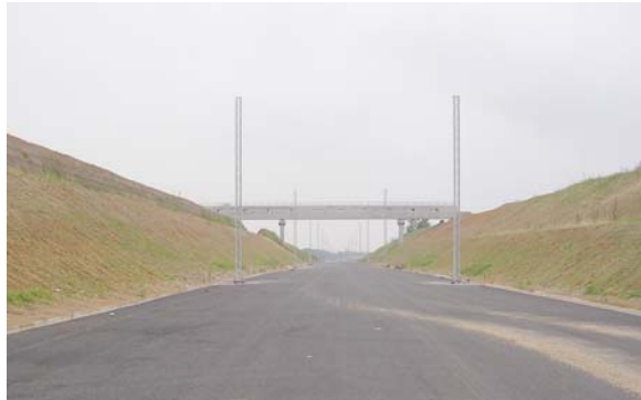
Luglio 2004 TR 03 – Trincea da PK 48+250 a PK 48+820. Posa sub-ballast
