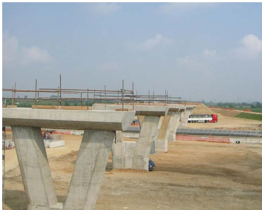
Luglio 2004 IV 16 – Sovrappasso su A4 e AC. Svincolo Chivasso est. Realizzazione appoggi travi
