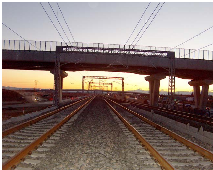
Dicembre 2004 RI 23 – Rilevato ferroviario. Vista ovest
