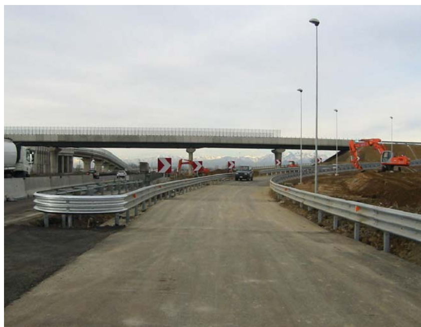
Dicembre 2004 IV 16 – Sovrappasso su A4 e AC. Svincolo Chivasso est
