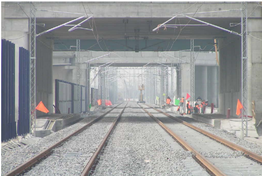
Dicembre 2004 SF 02 - Armamento da PK 1+000 a PK 15+000. Lavori lungolinea
