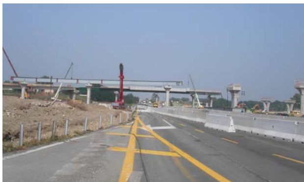
Luglio 2004 IV 47 – Sovrappasso su A4 rampa Torino-Balocco. Varo travi metalliche
