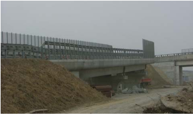
Dicembre 2004 IV 60 – Sovrappasso su area interclusa rampa Arona-Milano. Completamento viadotto
