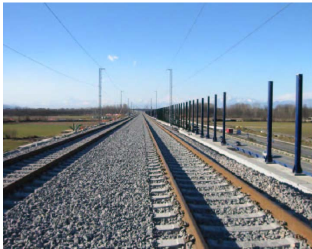
Dicembre 2004 RI 14 - Rilevato da PK 13+404 a PK 14+032. Posa montanti per barriere antirumore a destra
