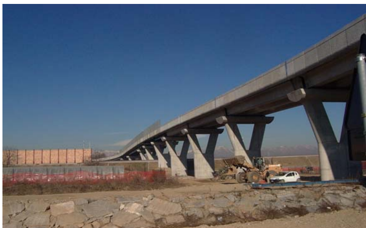
Dicembre 2004 IV 10 – Ponte nuova strada comunale su Malonetto. Realizzazione cassonetto stradale
