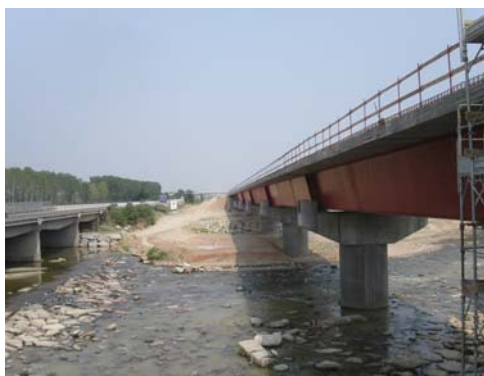
Luglio 2004 VI 22 - Viadotto Cervo. Vista lato nord
