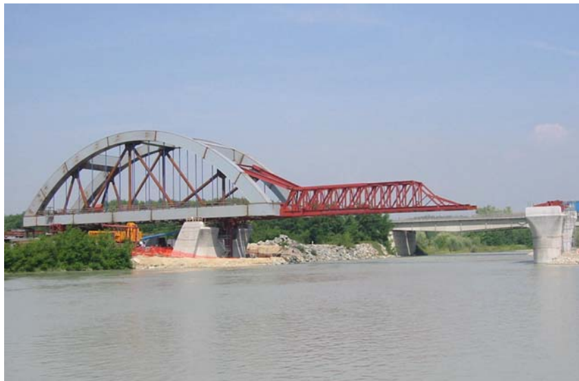
Luglio 2004 VI 14 - Viadotto Dora Baltea. Varo 1 a campata. Impalcato metallico
