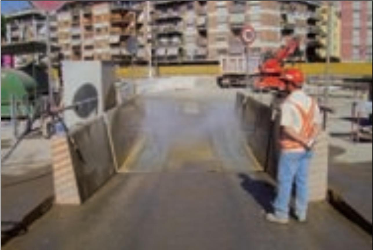
Passaggio obbligato degli autocarri su griglia di lavaggio per l'asportazione dei fanghi dalle ruote e dalla carrozzeria
