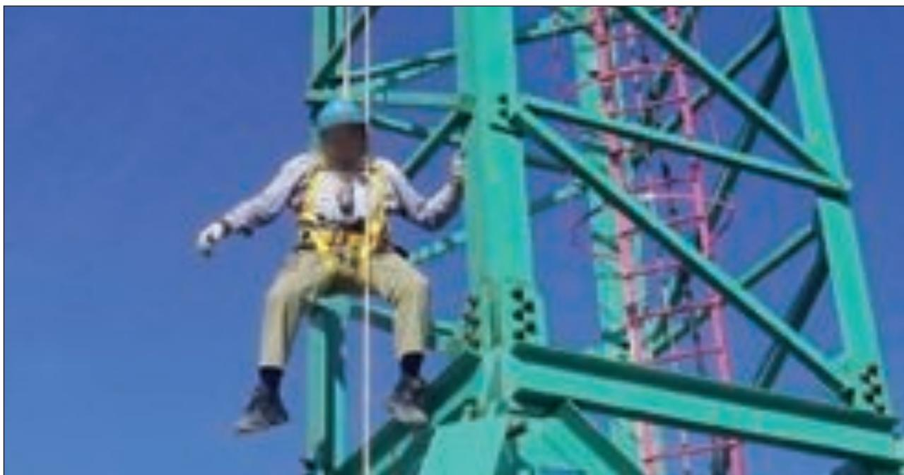
Esempio di sospensione passiva in un sistema di arresto caduta
