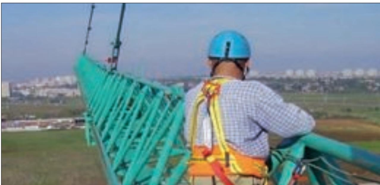
Sistema di arresto caduta nel montaggio di una gru a torre
