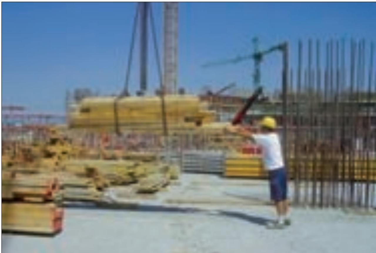
Posizione di lavoro dell'operatore che riceve e guida il carico trasportato da una gru a torre
