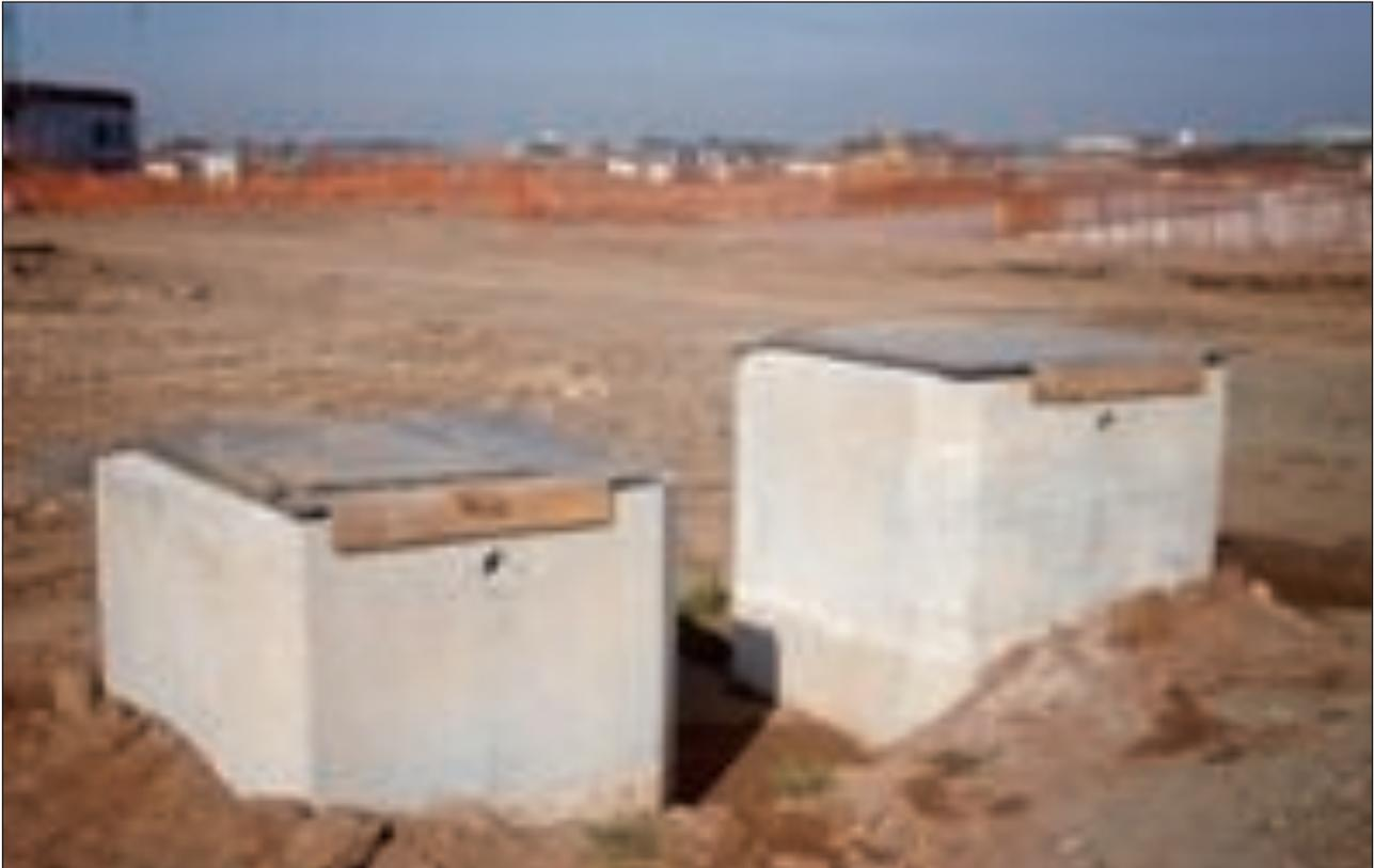
Opere di urbanizzazione. Pozzetti con bordo di altezza inferiore al metro, protetti con solide coperture
