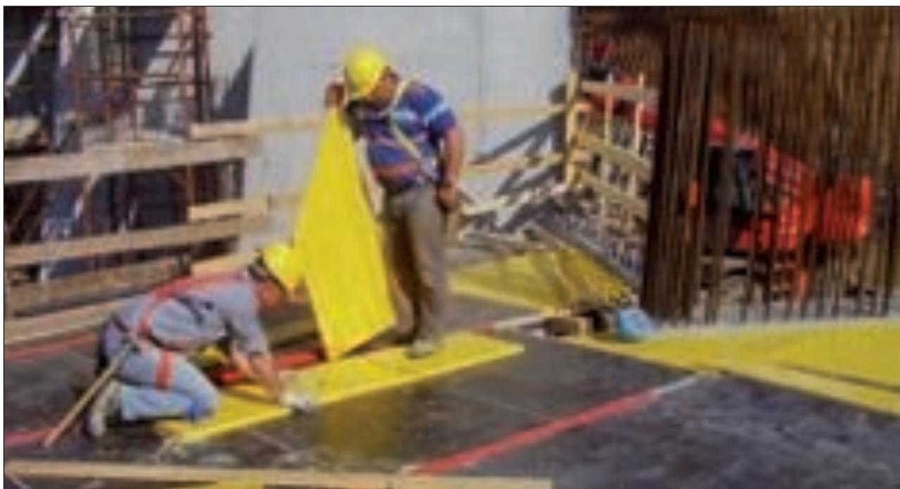
**Finitura dall'alto delle aperture residue di una carpenteria modulare di solaio**
