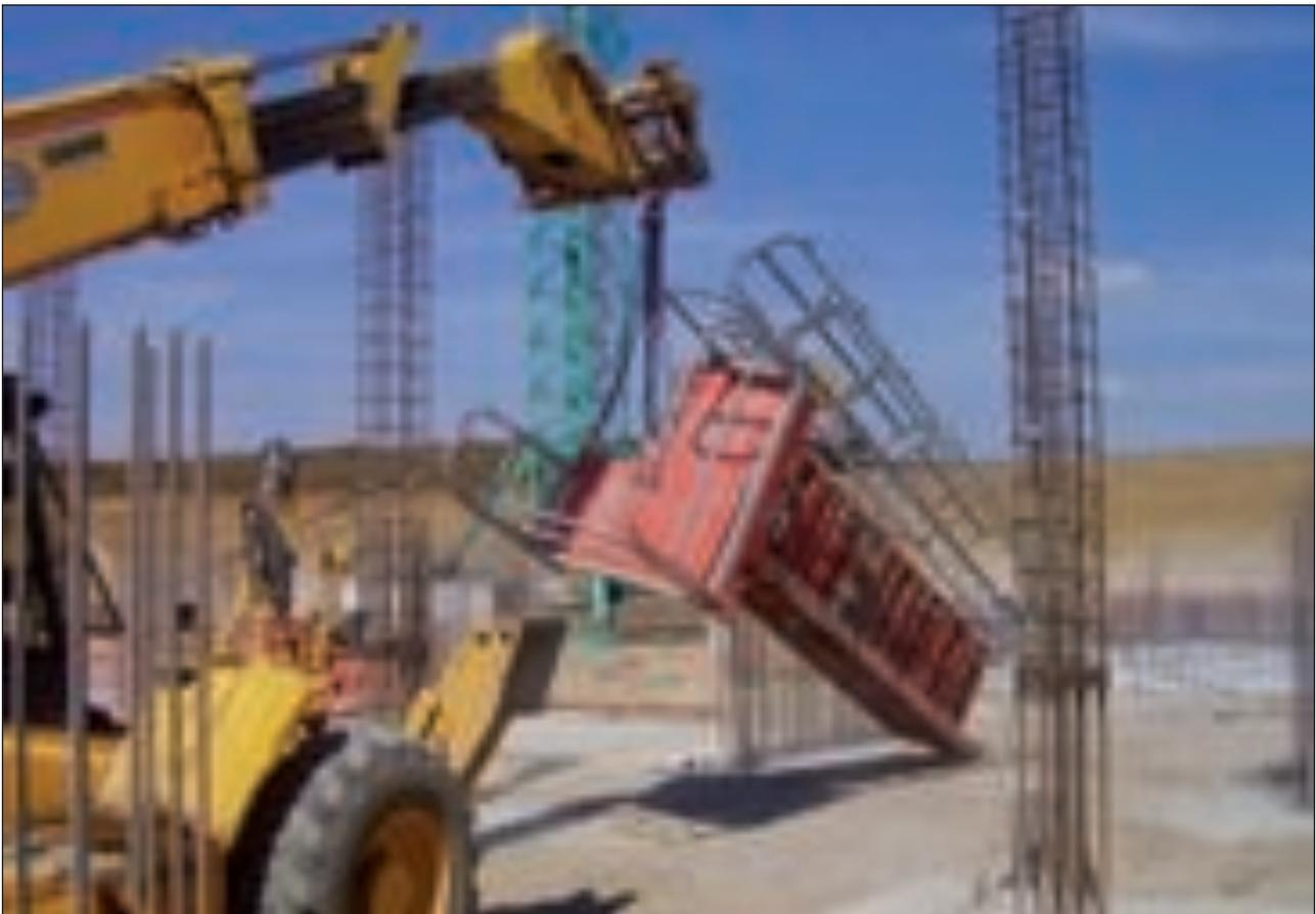
Erezione di una cassaforma prefabbricata per pilastri
