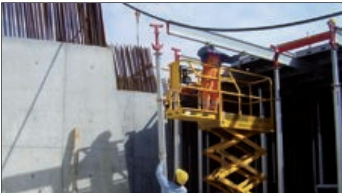
Sostegni della carpenteria modulare di un solaio. Accoppiamento trave puntello
