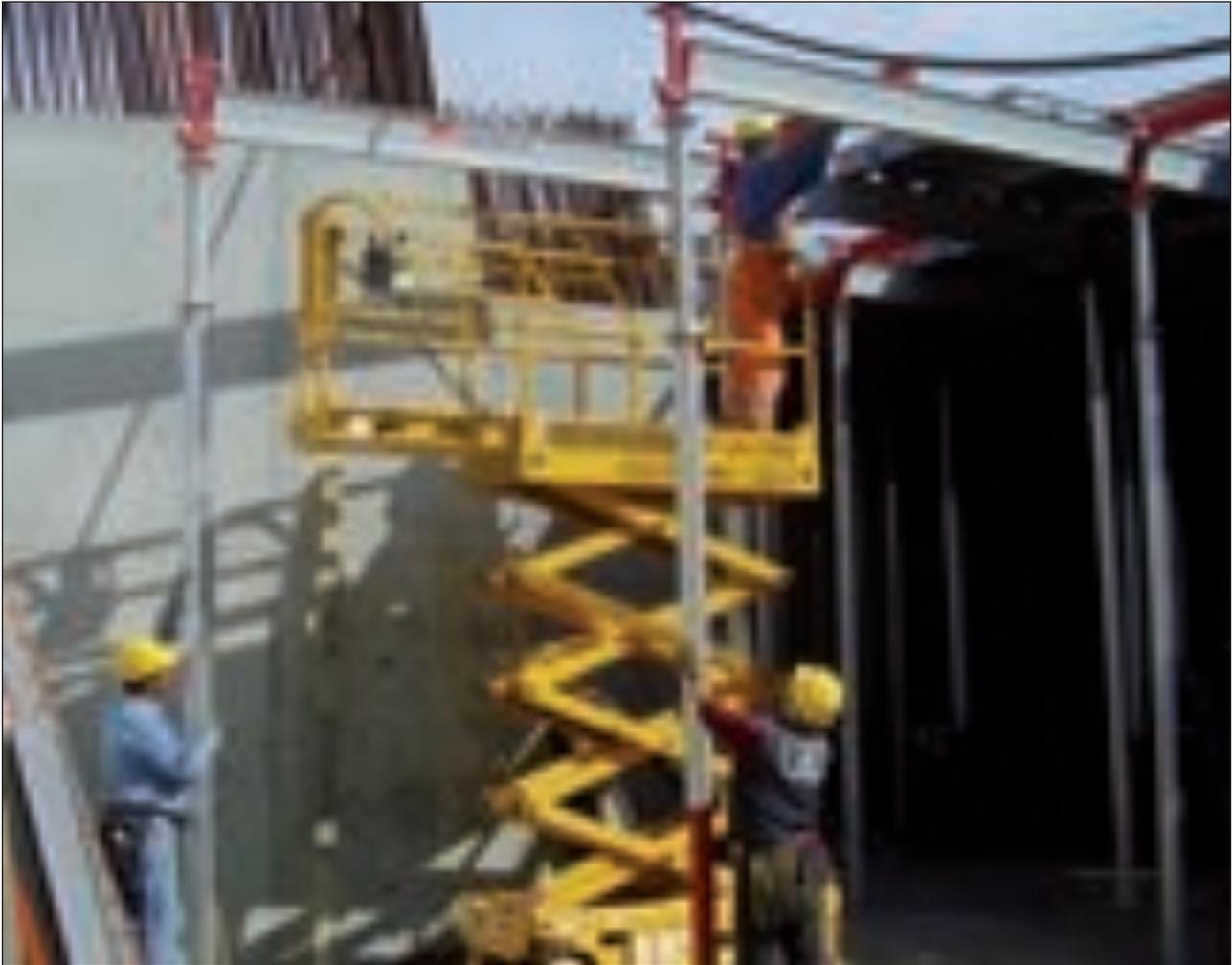
Sostegni della carpenteria modulare di un solaio. Sistemazione dei distanziali
