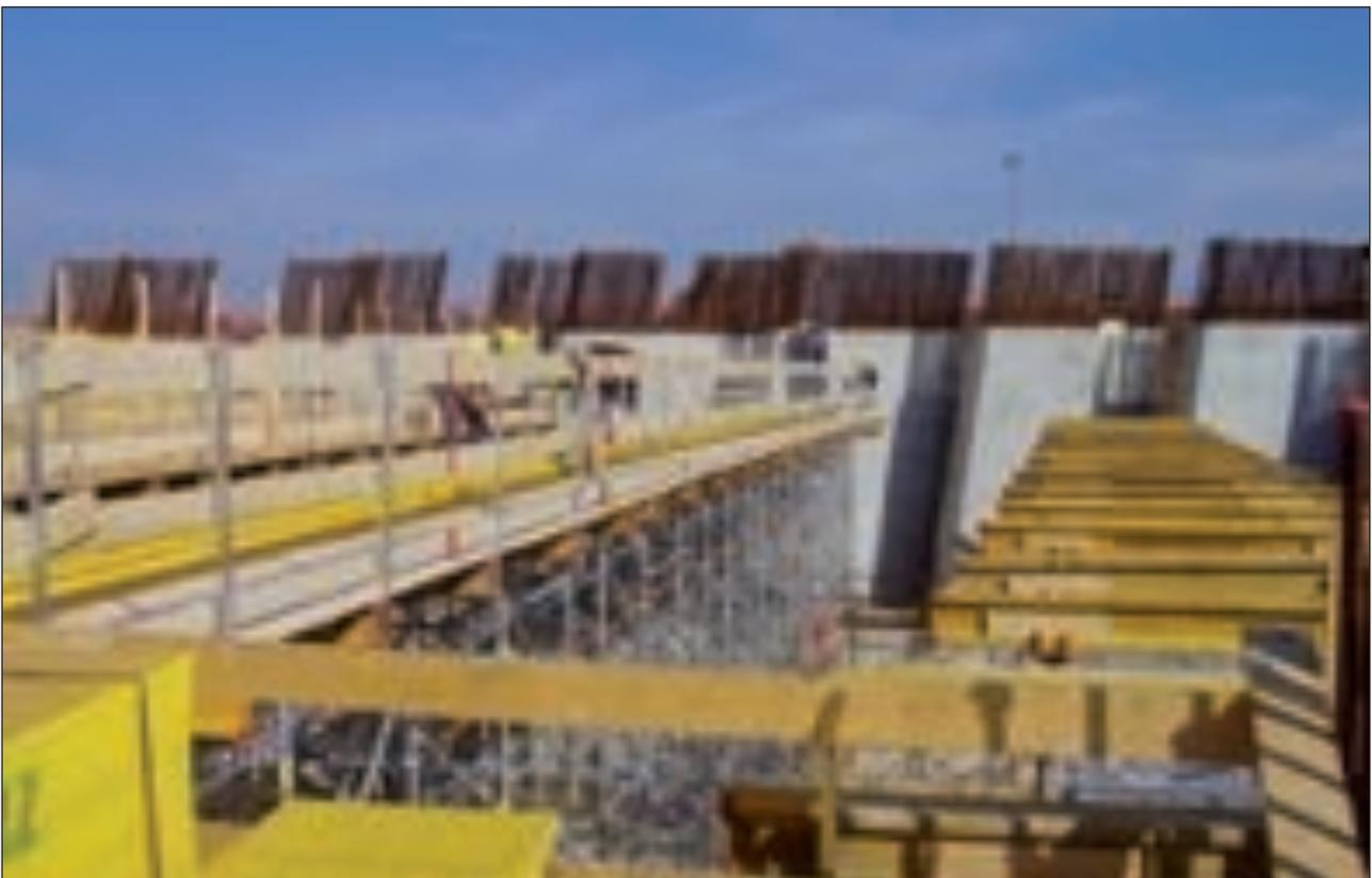
Costruzione di una cassaforma di trave a quota 8 metri. Impalcati di servizio e parapetti di protezione verso il vuoto, a sinistra. Strutture di sostegno in via di completamento, a destra.
