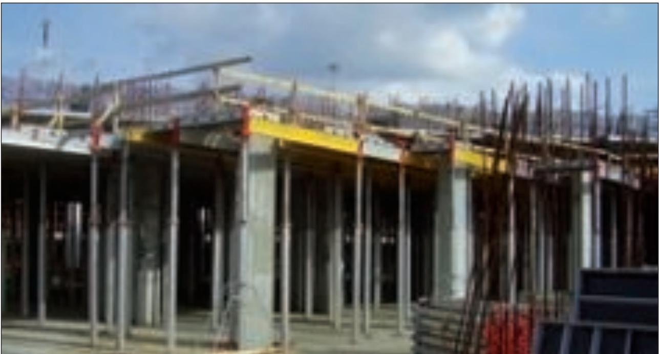
Parapetto installato su perimetro di carpenteria di solaio
