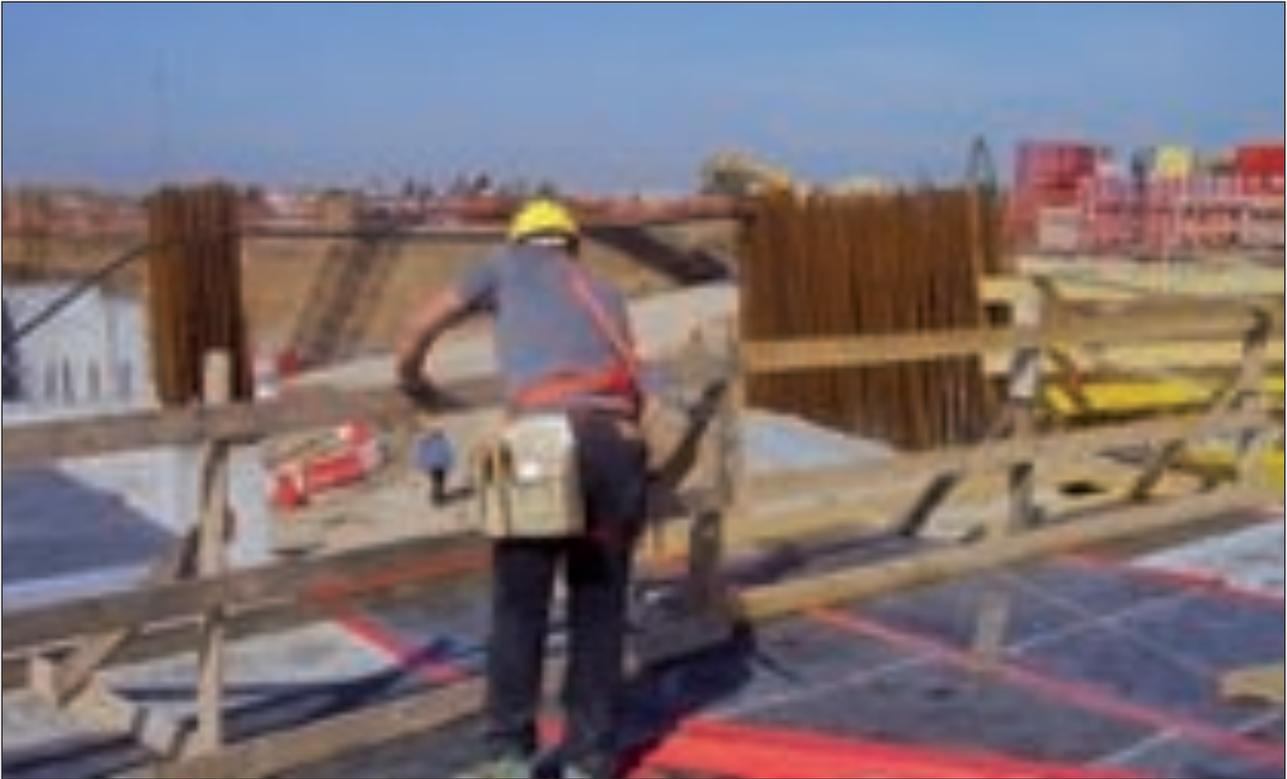
Installazione di parapetto prefabbricato da parte di lavoratore dotato di imbracatura e sistema di arresto
