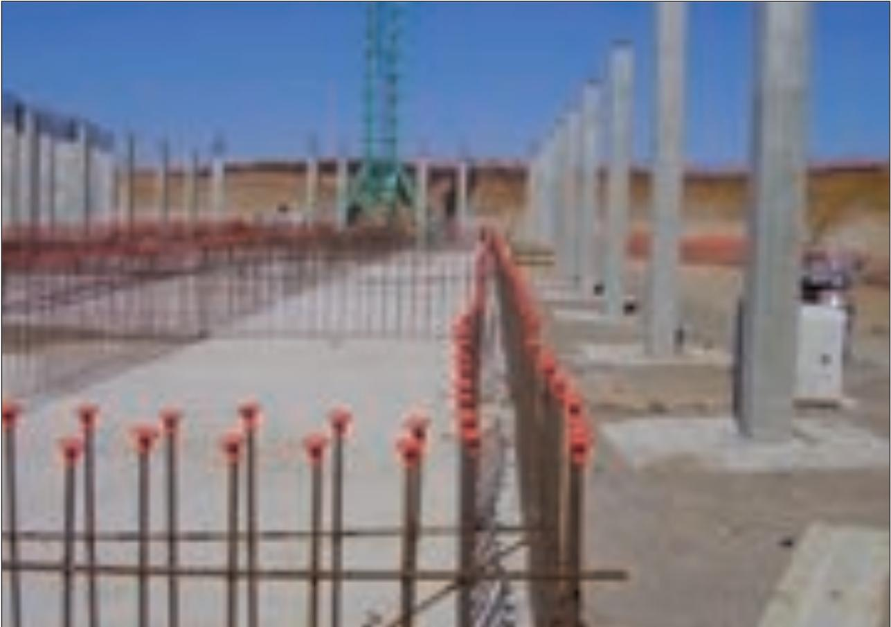
Protezione dei ferri di armatura con cappellotti di materiale plastico
