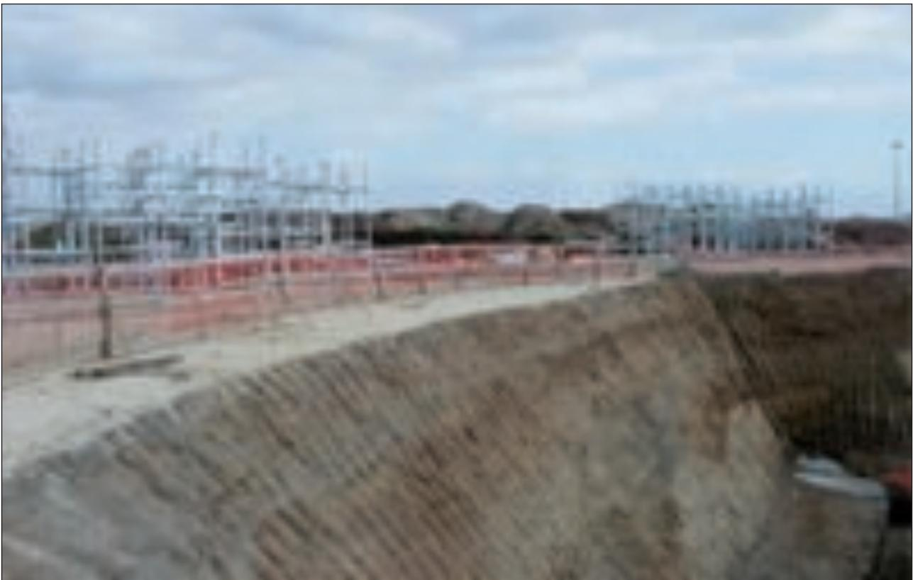
Area deposito strutture per opere provvisorie adiacente a zona scavo protetta con barriere in prossimità ciglio
