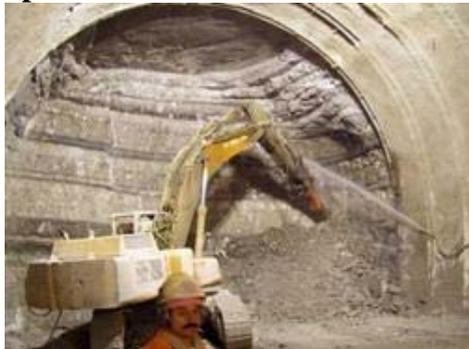
La lavorazione di scavo del fronte può essere realizzata con diverse modalità a secondo della tipologia di ammasso roccioso da scavare. Nella maggior parte dei casi si procede mediante l'utilizzo di esplosivo o attraverso l'uso di un escavatore dotato di "martellone". Successivamente, dopo aver rimosso porzioni di roccia instabile, si procede alla messa in opera di uno strato di calcestruzzo proiettato (spritz-beton).
