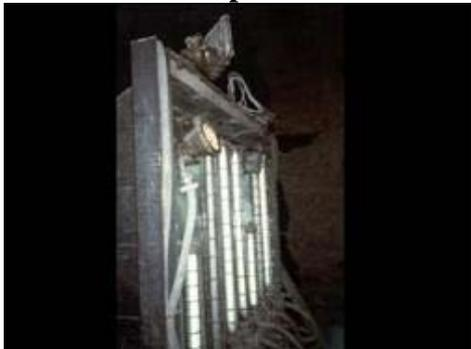
Corpi illuminanti alimentati da un piccolo generatore, loro accoppiato, mosso da una piccola turbina collegata all'impianto dell'aria ad alta pressione di cantiere
