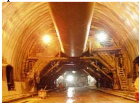
La fase di lavoro in oggetto consiste nella realizzazione del rivestimento definitivo di calotta e piedritti; tale operazione viene eseguita mediante casseri metallici studiati e realizzati in collaborazione con costruttori.
