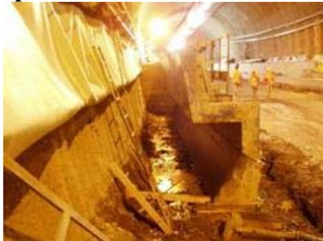
Le murette fanno parte, insieme alla calotta e all'arco rovescio, del rivestimento definitivo della galleria. Le murette, rispetto alle altre due opere sono eseguite per prime e sono utilizzate come appoggio dei binari sui quali avanzano il ponte per l'impermeabilizzazione della volta e delle pareti, il cassero per il getto della calotta ed il ponte semovente per la costruzione dell'arco rovescio.
