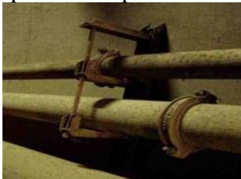
Nelle gallerie l'aria compressa viene utilizzata per alimentare utenze quali attrezzature pneumatiche perforatrici, chiodatrici, martelli, mole, giraviti, trapani, pompa spritz beton, seghe circolari ad azionamento
