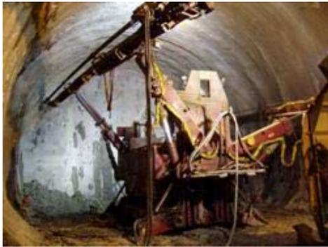
I fornelli da mina per lo scavo con esplosivo sono costituiti da fori
