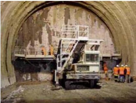
Piattaforma di lavoro atta a ricevere persone e attrezzature per un lavoro specifico, installata su propri carro di base, avente la possibilità di essere variato in quota rispetto a quella di riposo per l'intervento di apparecchiature afferenti ad un sistema oleodinamico costituito da cilindri/pistoni a doppio effetto.
