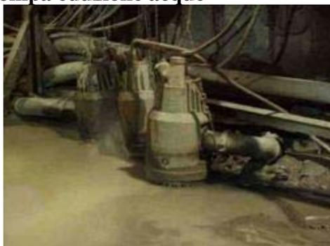
Pompa idrica ad immersione usata per aggottare cqua e fango da pozzetti e canali di raccolta delle acque. L'alimentazione delle pompa può essere elettrica, ad aria compressa o a motore endotermico
