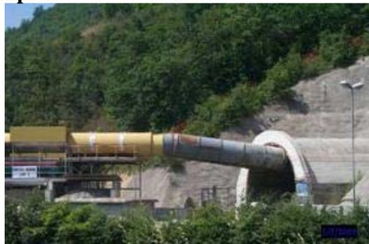
Per realizzare lavori di scavo in sotterraneo vengono predisposti impianti di ventilazione che hanno compito di immettere una quantità di aria fresca pulita sufficiente in modo da garantire una corretta diluizione degli agenti inquinanti prodotti,
