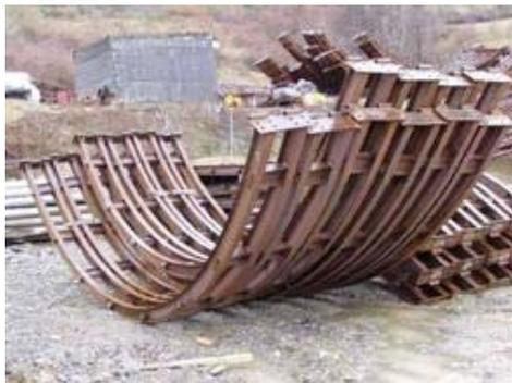
Profilato metallico di forma curvilinea usato per l'armatura della volta della galleria.
