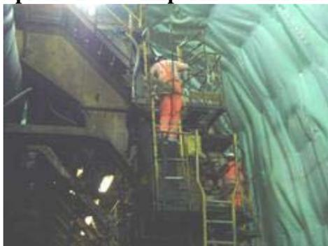
L'impermeabilizzazione di una galleria è necessaria per evitare la percolazione delle acque nel suo interno; ciò al fine di assicurare la maggiore durata dell'opera. La fase consiste nell'applicare su tutto il profilo della galleria (pareti e volta) ed anche alle eventuali nicchie, una pellicola di tessuto non tessuto e una guaina di PVC. L'impermeabilizzazione è eseguita successivamente al pririvestimento e alla realizzazione delle murette.
