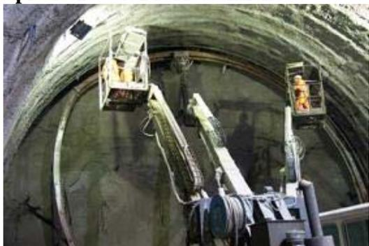
Il Prerivestimento è una fase immediatamente successiva allo scavo che, a seconda della tipologia di terreno attraversato, viene realizzata con varie metodologie quali la posa in opera di bulloni radiali centine.
