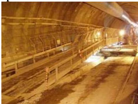
L'arco rovescio è una struttura in calcestruzzo talvolta rinforzata da armatura in ferro concepita e costruita in maniera tale da dare
