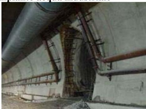
L'acqua industriale viene utilizzata principalmente negli impianti di betonaggio, nelle officine e per l'effettuazioni di alcune fasi lavorative quali l'esecuzione dei fori da mina, il preconsolidamento del fronte e lo smarino. Essa inoltre si rende necessaria per l'abbattimento delle polveri durante lo scasso a martellone e per l'alimentazione della rete idrica antincendio.
