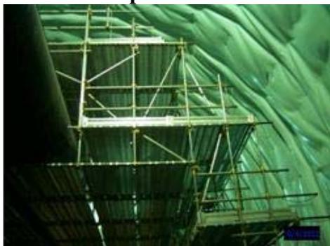
Struttura a tubi e giunti o in carpenteria metallica (ponteggio), sagomato secondo il profilo della galleria, dotato di piani di lavoro utili alla posa in opera dei ferri di armatura e dei teli per l'impermeabilizzazione. Il ponte lascia lo spazio necessario al transito dei mezzi ed è costruito in modo da sostenere la tubazione di areazione. Il ponteggio su ruote in gomma viene traslato mediante il tiro con funi.
