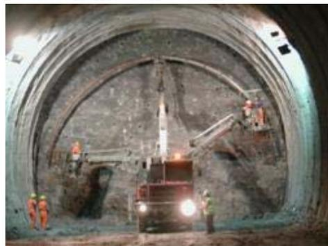
Macchina dotata di carro di base proprio sul quale sono installati un braccio telescopico dotato di pompa idraulica per il sollevamento, posizionamento e sostegno della centina e ponti sviluppabili con indipendenti dal braccio portapinza, per le operazioni di finitura del montaggio.
