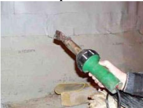
Apparecchio portatile elettrico a bassa tensione che produce aria calda ad elevata temperatura utilizzato per saldare ed unire i teli in pvc per l'impermeabilizzazione della galleria.
