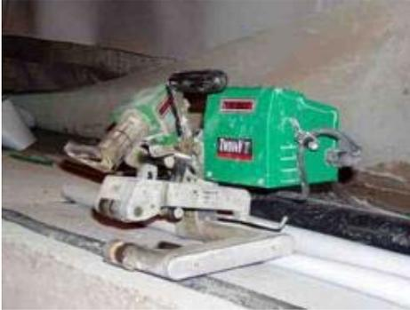
Apparecchio elettrico a bassa tensione mobile azionato manualmente, dotato di rulli contrapposti riscaldati, utilizzato per unire i teli in pvc della l'impermeabilizzazione della galleria.
