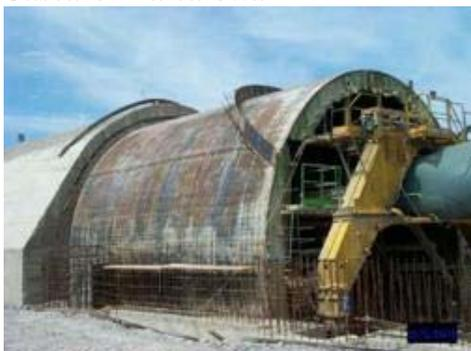
Struttura autoportante in metallo, dotata di carro portaforme di tipo a portale con gambe telescopiche e
