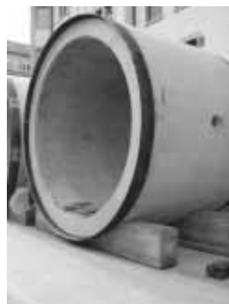
Fig. 2: deposito per lo stoccaggio temporaneo dei tubi di spinta.
