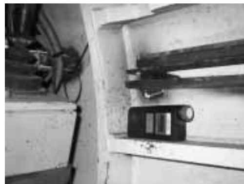
Fig. 3: per lavorare in condizioni di sicurezza è fondamentale che il luogo sia ben illuminato e che la qualità dell'aria sia costantemente monitorata.
