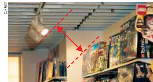
7 Evitare gli incendi: tenere la dovuta distanza dalle fonti di calore prodotte dalle lampade spot.
