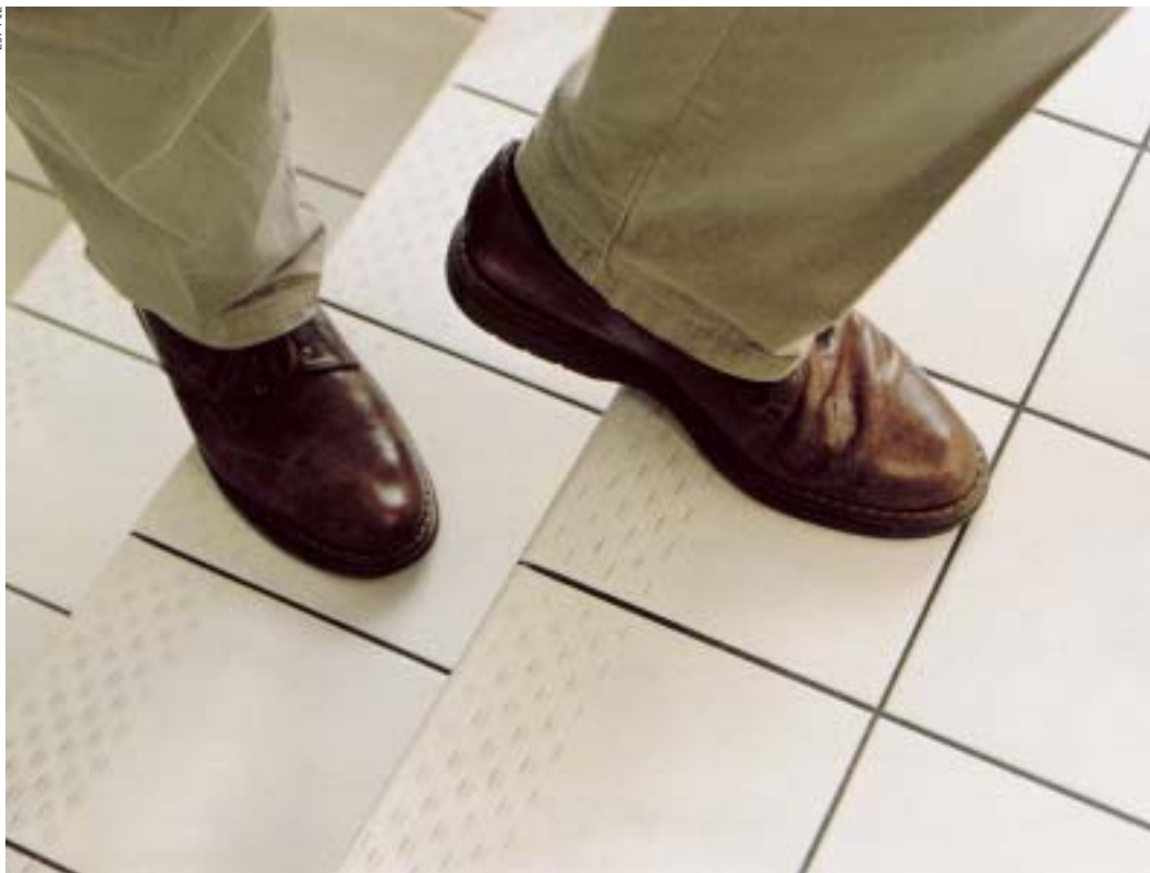
③ Gradini con bordi antiscivolo servono a evitare la caduta di persone.
