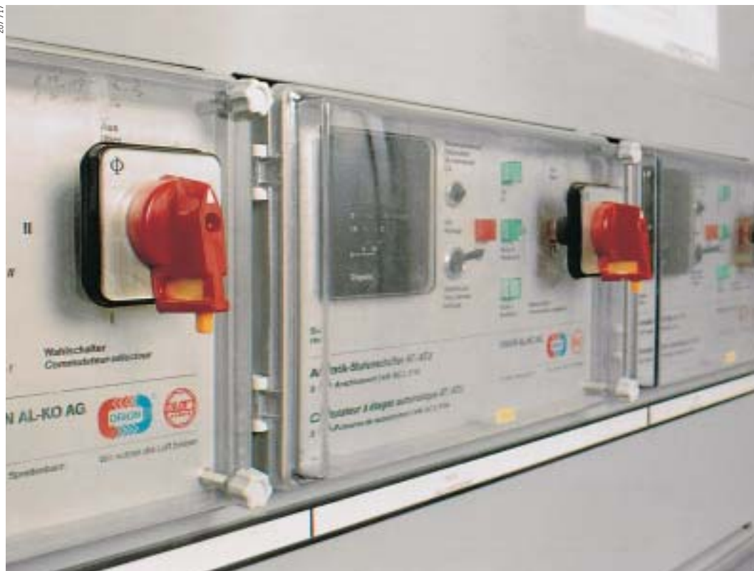
7 Interruttore chiudibile a chiave per ogni singola unità di funzionamento.
