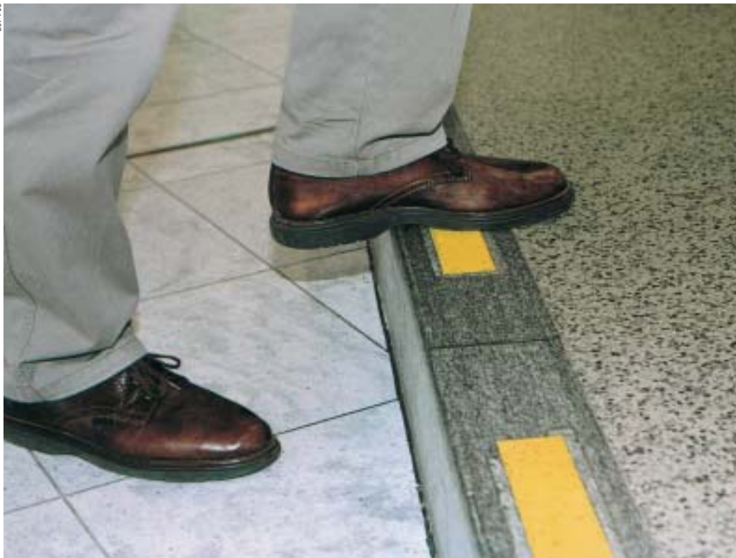
4 Gradino segnalato e illuminato convenientemente.
