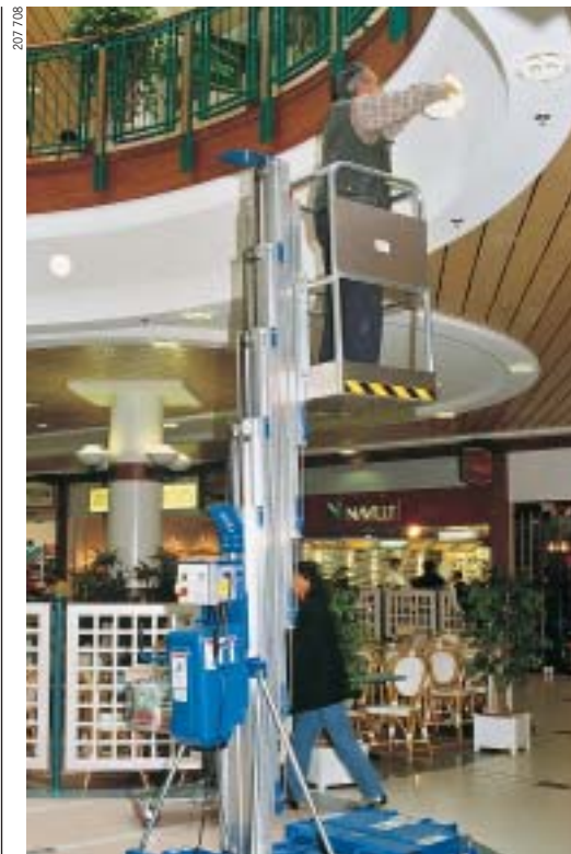
Piattaforma di sollevamento quale installazione per eseguire la manutenzione in sicurezza.
