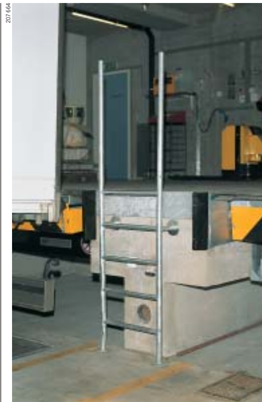
Scala con montanti quale accesso sicuro di una rampa.
