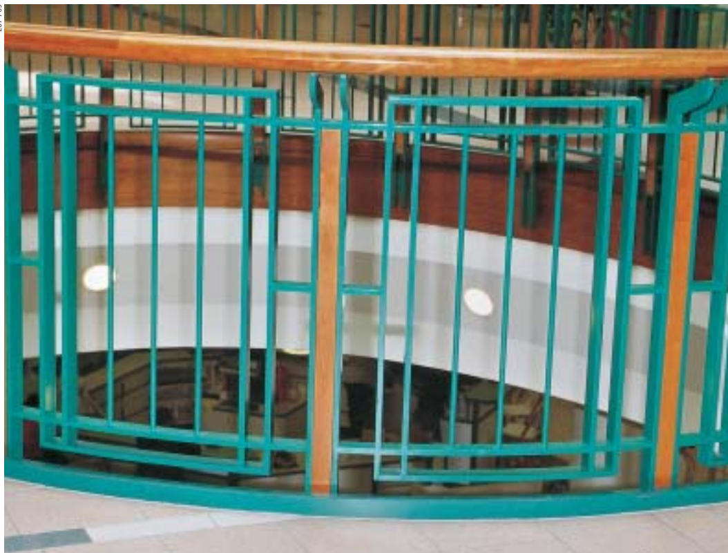
Correnti intermedi verticali e bordature fermapiede quali elementi di sicurezza e d'ornamento.
