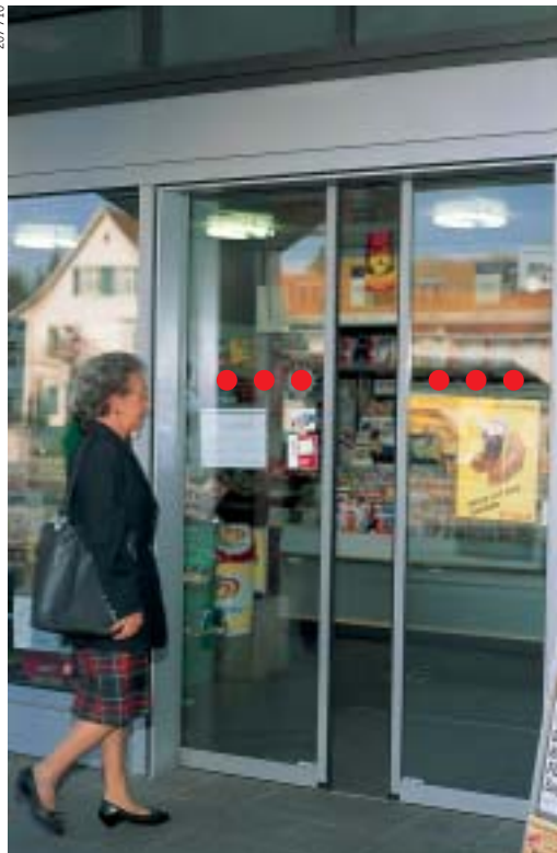
❶ Porta automatica con specchiatura vetrata contrassegnata convenientemente.
