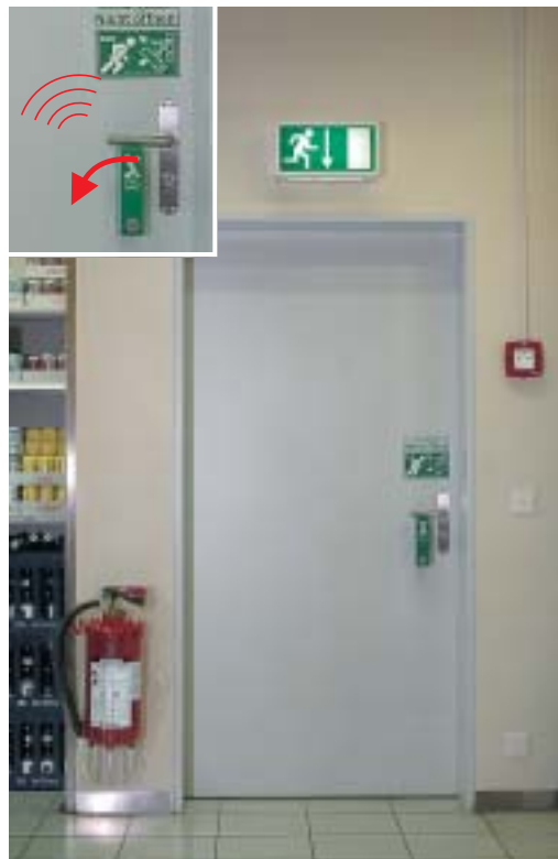
5 Non bloccare le uscite di sicurezza, munirle solo di un dispositivo di sorveglianza.
