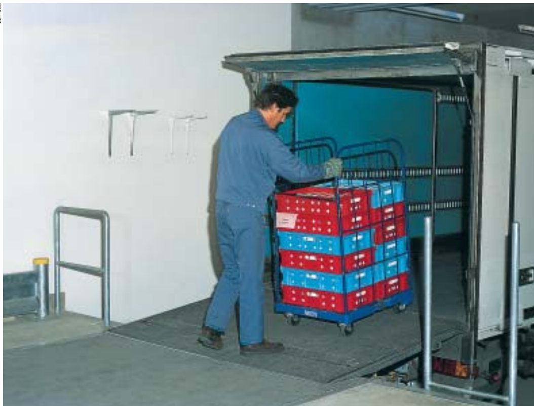
Passaggio antisdrucciolevole fra rampa e veicolo.
