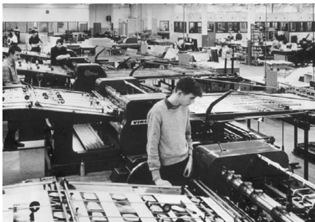
Figure 85.1 • Finition après impression: la bande continue est découpée en feuilles puis façonnée pour obtenir le produit fini
