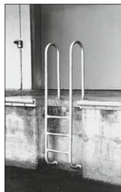
Le scale fisse a pioli possono servire per completare le scale a gradini o le rampe d'accesso, ma non per sostituirle.
