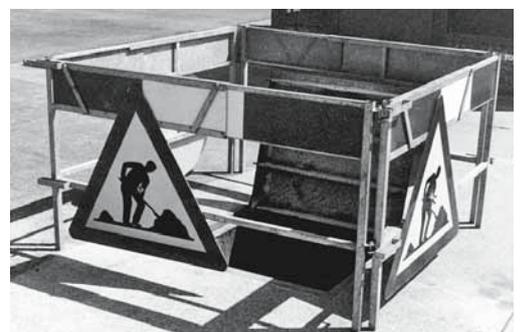
Fig. 10: sbarramento di uno scavo.
