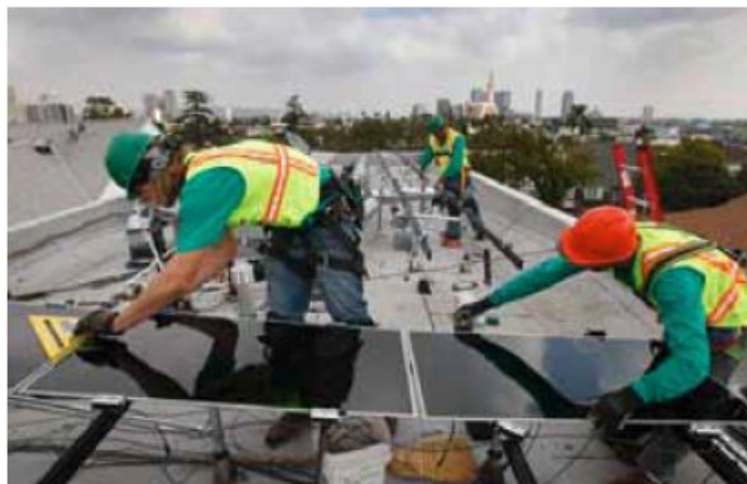
Installazione di pannelli solari
