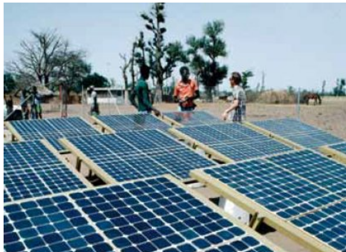
Pannelli solari fotovoltaici in Senegal
