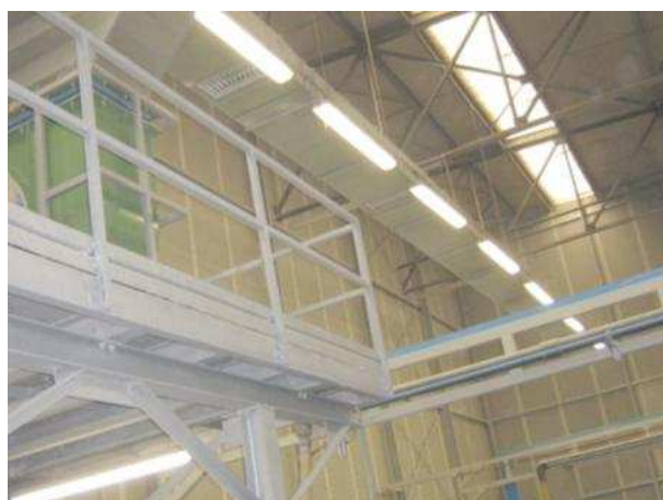
immissione nell'alto della cabina di aria esterna: volume di estrazione > volume immissione.
