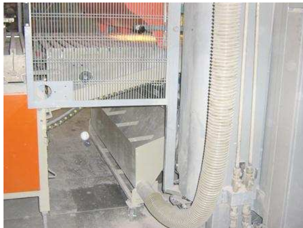
Tramoggia mobile aspirata per la raccolta delle polveri, posizionata sotto la rulliera.
