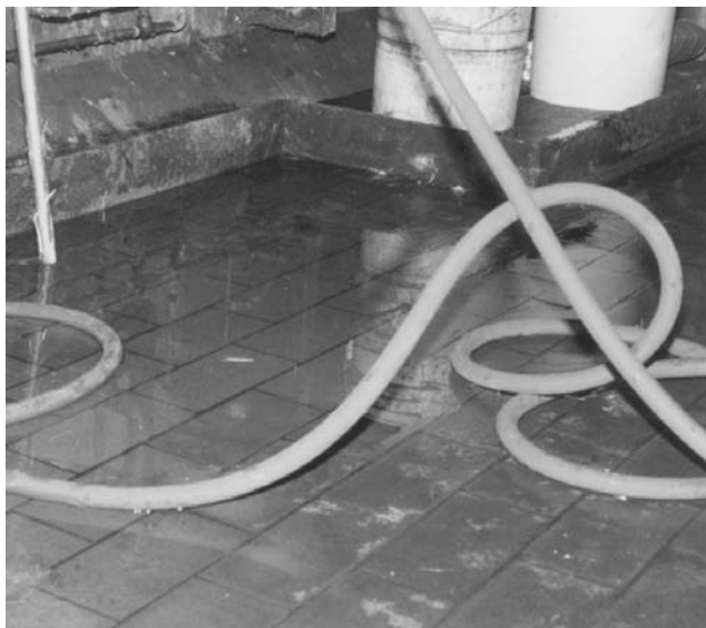
Figure 84.21 • Les zones de travail et de circulation ne doivent pas être encombrées, ni les sols glissants pour exclure le risque de chute
