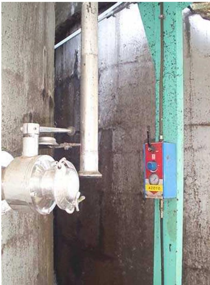
**Fig. n. 13** Presa dell'azoto tra i *fermentini* coibentati.
