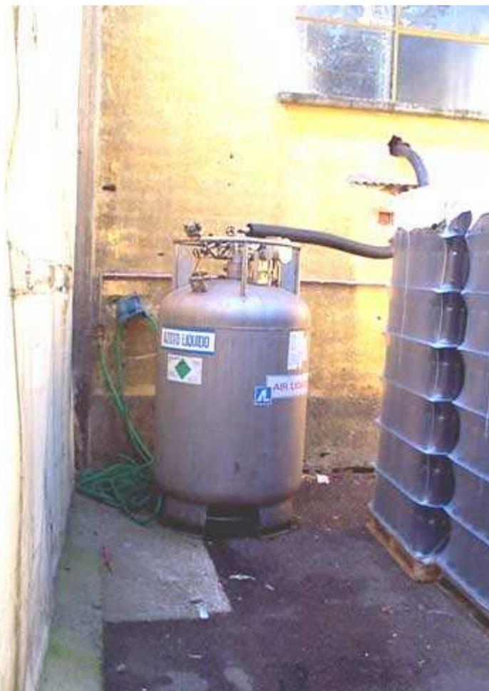
**Fig. n. 50 Recipiente fisso di azoto liquido installato all'esterno del reparto di imbottigliamento del vino (il cui riempimento avviene a cura di ditte fornitrici specializzate).**
