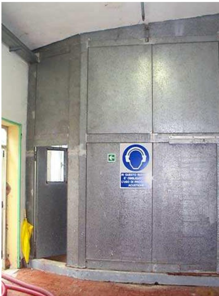
**Fig. n. 38 Separazione acustica del locale dove sono installate le macchine rumorose.**
