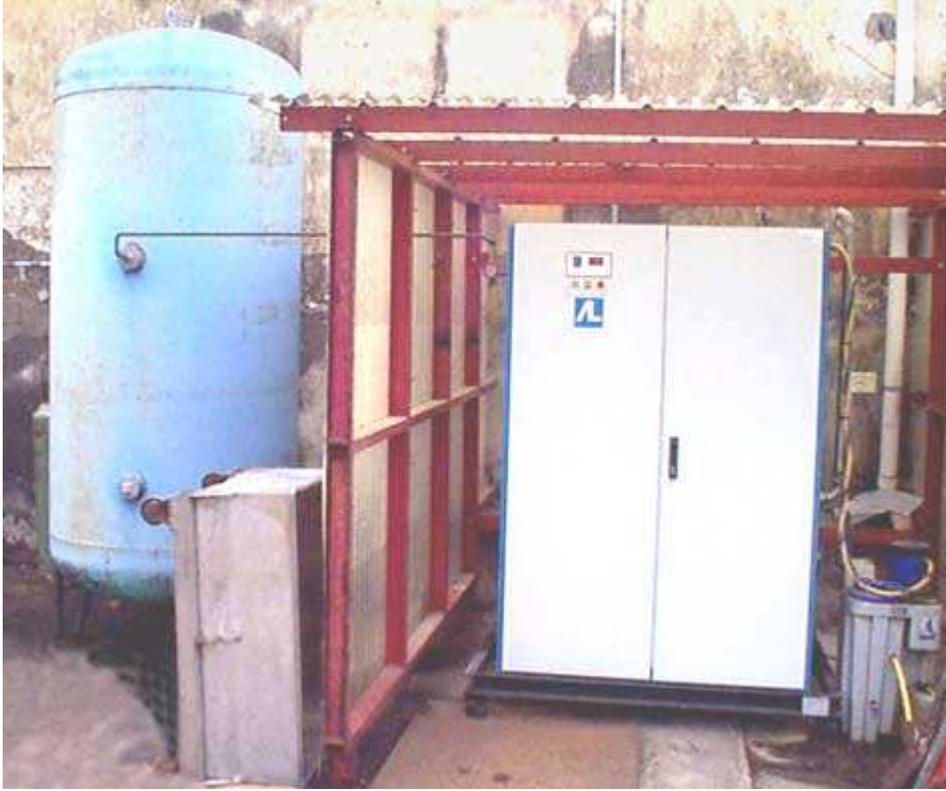
**Fig. n. 14 Generatore di azoto.**
