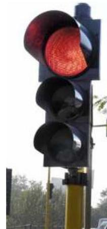
Il semaforo va posto sul lato destro della carreggiata. Nel caso in cui il traffico si possa disporre su più file, deve essere posizionato un ulteriore semaforo sul lato sinistro della carreggiata.
