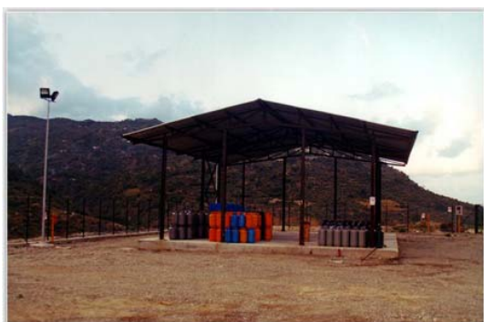
Locale di deposito
